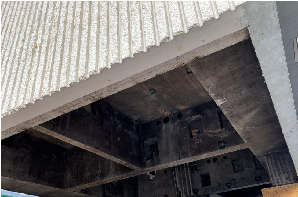
019: Detail konstrukce železobetonových žeber konzoly severozápadního nároží, 2021 (archiv vlastních fotografií).
