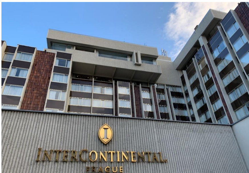
017: Stav západního průčelí krátce před začátkem rekonstrukce, 2018 (archiv vlastních fotografií).
