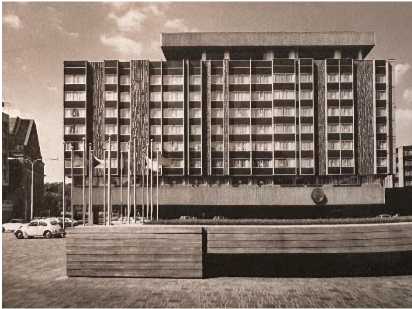
005: Jižní průčelí hotelu s volnou plochou vyvažující objem budovy (1).
