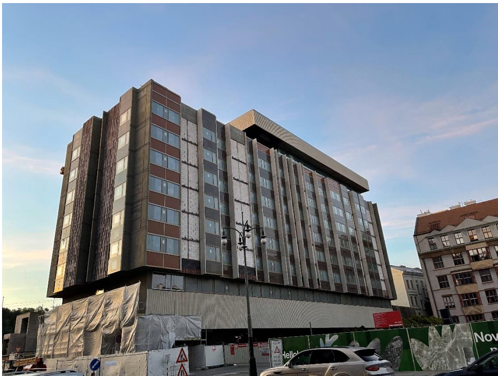
024: Probíhající rekonstrukce, pohled na jižní průčelí z ulice Pařížská, 2022 (archiv vlastních fotografií).
