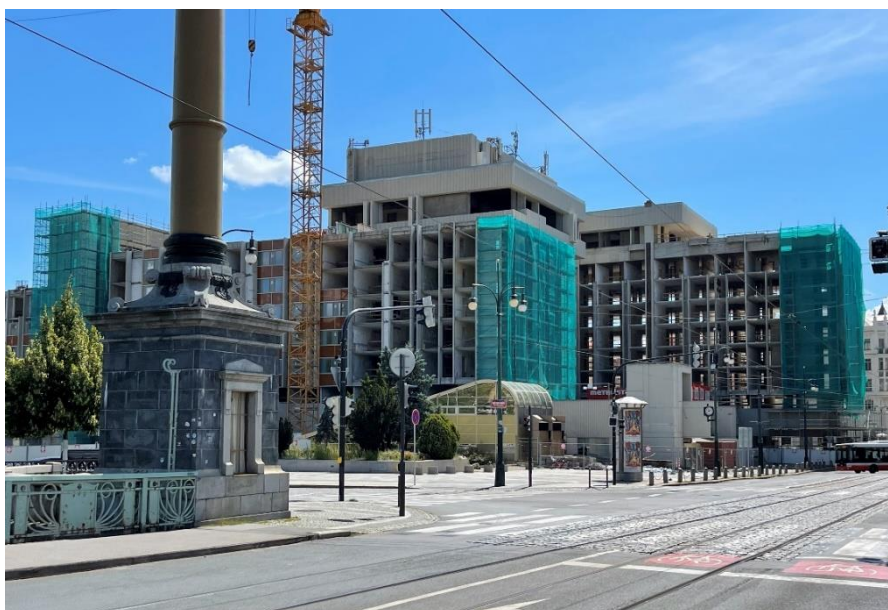
018: Probíhající práce na kompletním odstojení původní fasády, 2021 (archiv vlastních fotografií).
