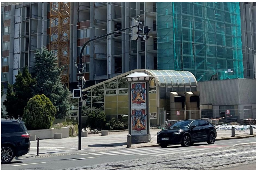
016: Objekt hotelového wellness s bazénem krátce před demolicí.
