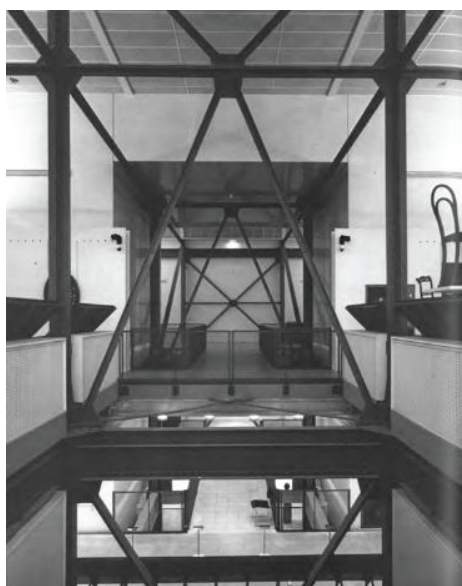
Obr. 25: pohled do interiéru pavilonu Amont
