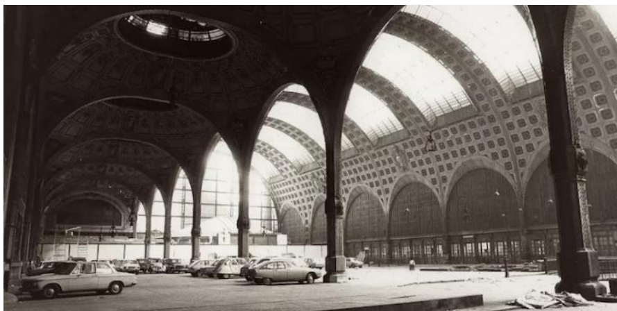
Obr. 7: pohled na budovu nádraží v době, kdy sloužila jako parkoviště (po roce 1939)
