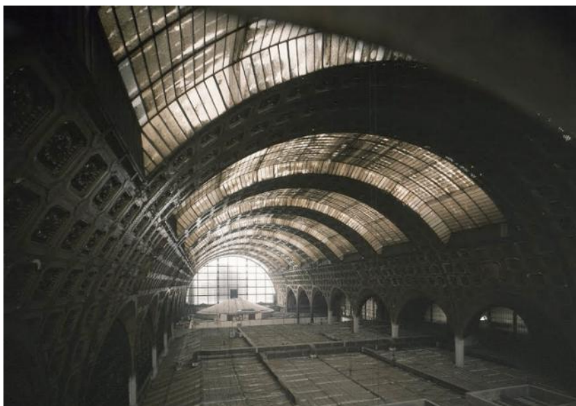
Obr. 6: pohled na budovu nádraží v době, kdy sloužila jako sídlo divadelní společnosti Madeleine Renaud-Jean-Louis Barrault (po roce 1939)
