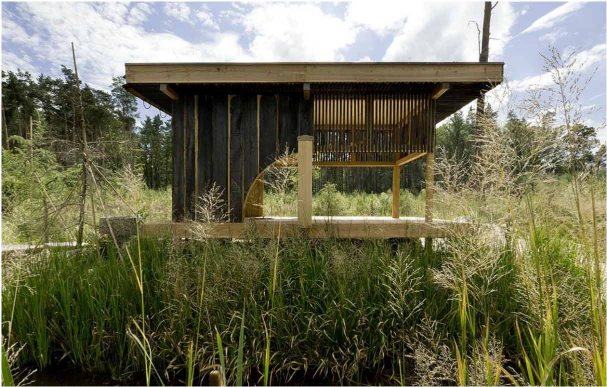
10 Pohled na čajový dům
