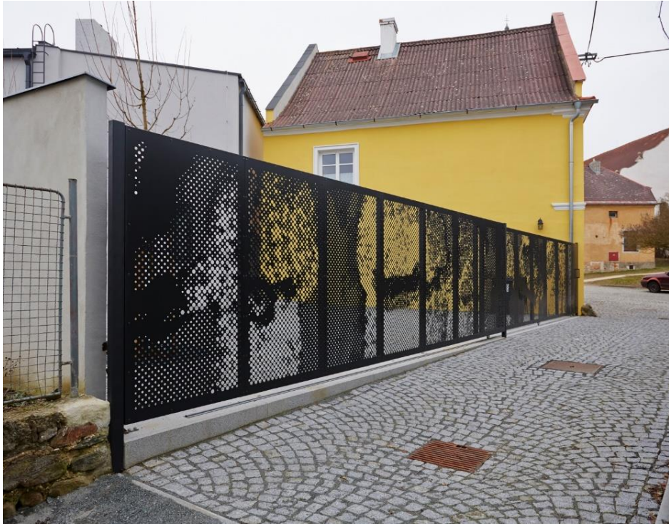
obr. 09 – Nové oplotenie z perforovaného plechu
