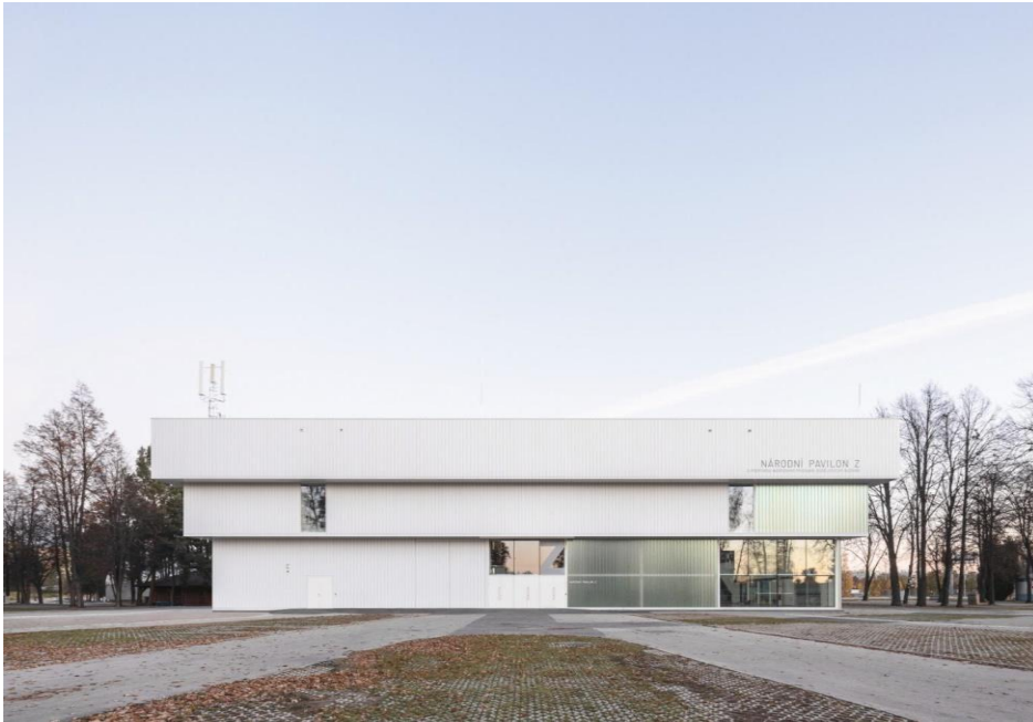
Obrázek 11 - Zrekonstruovaný Pavilon Z
