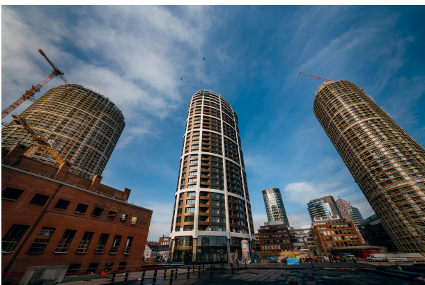
Obr. 11 - Fotografia výstavby 1. časti
