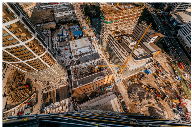
Obr. 12 - Fotografia výstavby 1. časti
