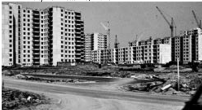
OBR. 6 Nedobudovaná občanská infrastruktura; Sídliště Vinohrady, Brno; zdroj: bam.brno.cz, F. Kressa
