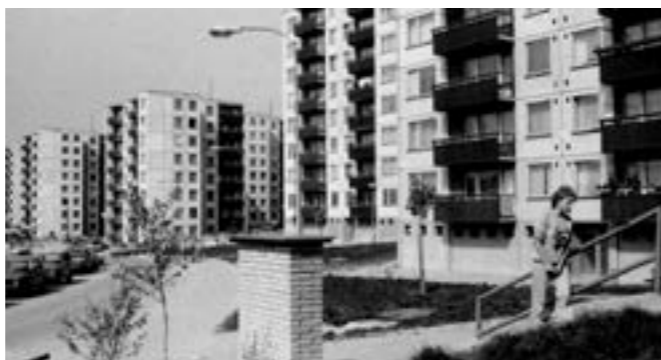
OBR. 2 Monofunkčnost; Sídliště Stará Líšeň, Brno; zdroj: bam.brno.cz, F. Kressa
