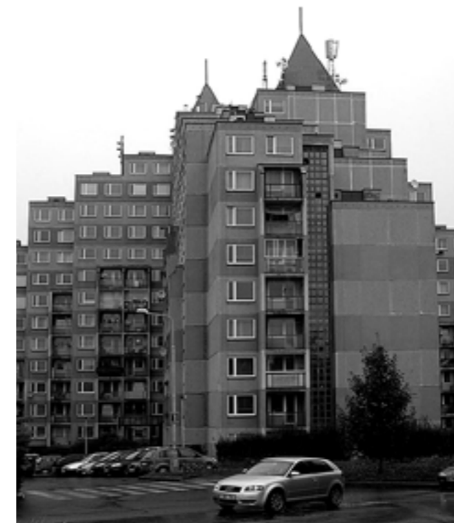
OBR. 29 Postmoderna – Barrandov, Praha, zdroj: commons.wikimedia.org
