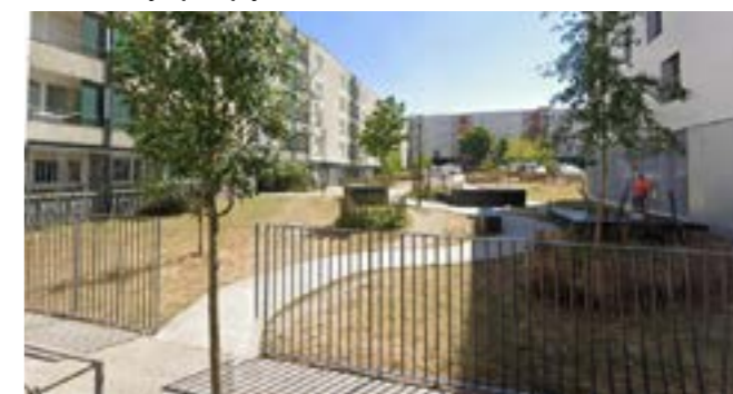
Obr. 36 Veřejný vstup stavebním blokem, Genicart, Lormont
