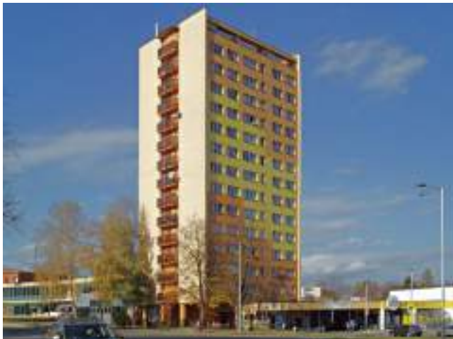
Obr. 134 Konstrukční soustava VOS, ulice Sokolovská, Ostrava – Poruba (Zdroj: Stanislav Endel)
