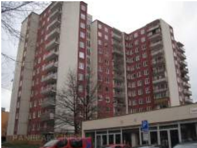
Obr. 54 Konstruktivní soustava B70 - Brno Vinohrady (Zdroj: panelaky.info)
