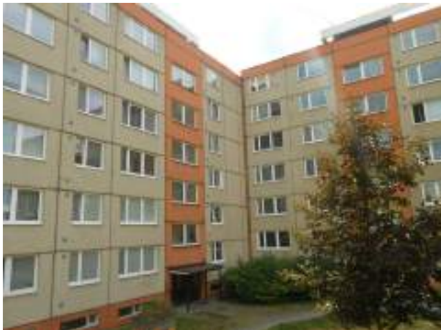
Obr. 183 Konstrukční soustava OP 1.11 (Zdroj: panelaky.info)
