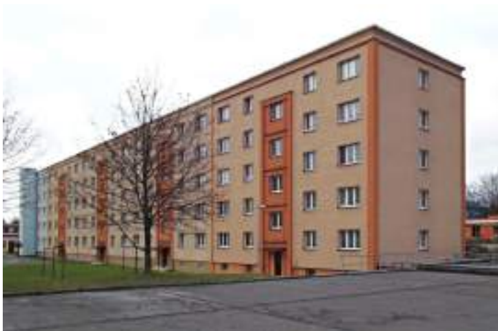
Obr. 120 Konstrukční soustava G57, ulice Porubská, Ostrava – Poruba (Zdroj: Stanislav Endel)
