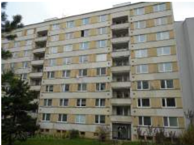
Obr. 21 Konstrukční soustava T06B (Zdroj: panelaky.info)
