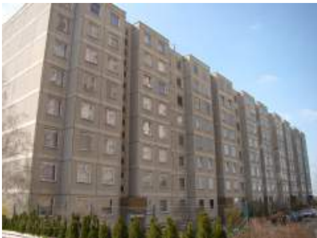
Obr. 107 Konstrukční soustava Larsen-Nielsen (Zdroj: panelaky.info)
