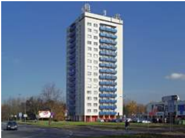
Obr. 136 Konstrukční soustava VM-OS, ulice Francouzská, Ostrava – Poruba (Zdroj: Stanislav Endel)
