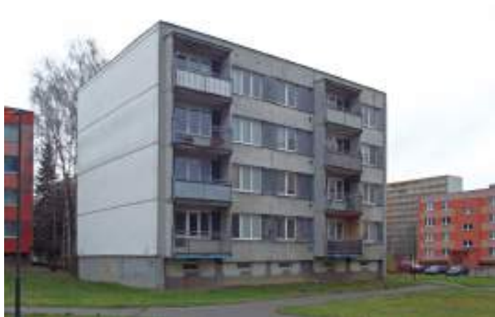
Obr. 132 Konstrukční soustava T06B-OS, ulice Otakara Jeremiáše, Ostrava – Poruba (Zdroj: Stanislav Endel)
