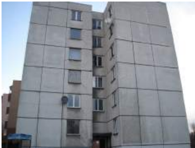
Obr. 63 Konstrukční soustava OP 1.11 (Zdroj: panelaky.info)
