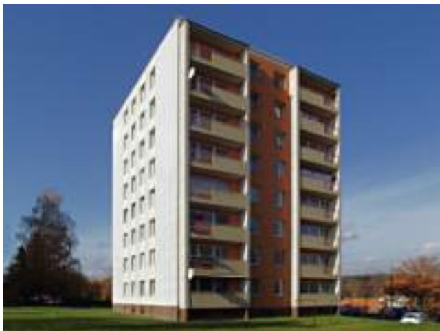
Obr. 128 Konstrukční soustava BP-70-OS, ulice Marie Majerové, Ostrava – Poruba (Zdroj: Stanislav Endel)
