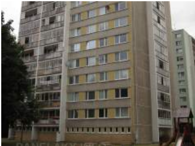
Obr. 35 Konstrukční soustava T08B - bodová sekce (Zdroj: panelaky.info)
