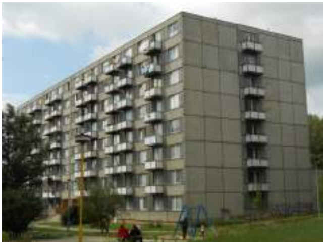
Obr. 11 Konstrukční soustava T06B (Zdroj: panelaky.info)
