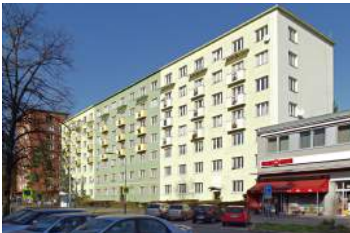
Obr. 122 Konstrukční soustava T02B-OS, Hlavní třída, Ostrava – Poruba (Zdroj: Stanislav Endel)
