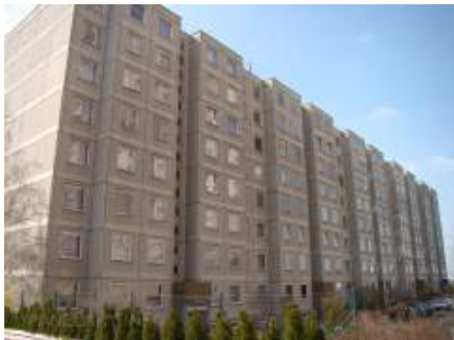
Obr. 172 Konstrukční soustava Larsen-Nielsen (Zdroj: panelaky.info)
