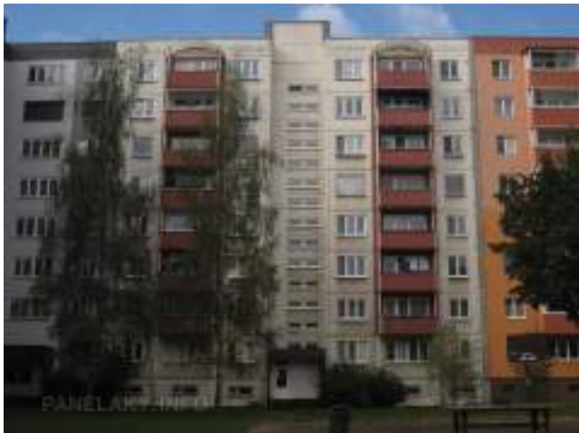
Obr. 86 Konstrukční soustava OP 1.31 - Haviřov (Zdroj: panelaky.info)
