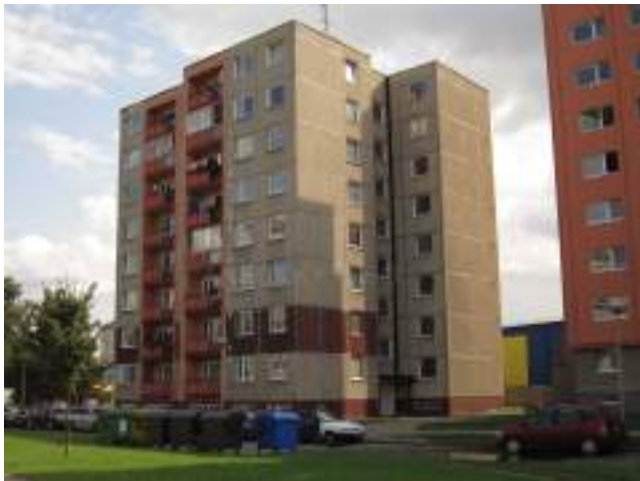
Obr. 62 Konstrukční soustava OP 1.11 (Zdroj: panelaky.info)
