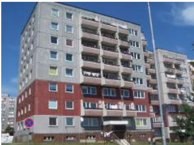
Obr. 90 Konstrukční soustava OP 1.31 - Havířov (Zdroj: panelaky.info)
