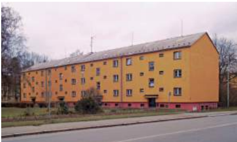
Obr. 116 Konstrukční soustava T11, ulice Dělnická, Ostrava – Poruba (Zdroj: Stanislav Endel)
