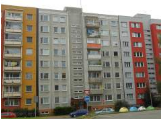
Obr. 79 Konstrukční soustava OP 1.31 - Nový Jičín (Zdroj: panelaky.info)
