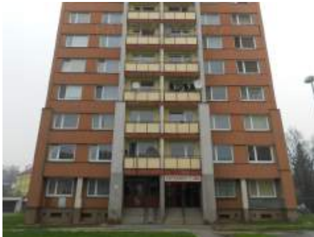
Obr. 113 Vstup do objektu (Zdroj: panelaky.info)
