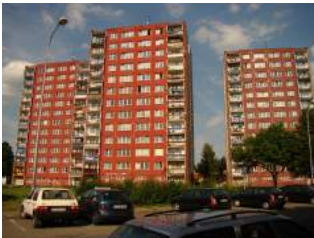
Obr. 74 Konstrukční soustava OP 1.13 (Zdroj: panelaky.info)
