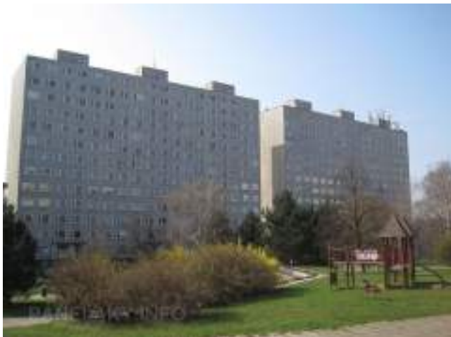
Obr. 38 Konstrukční soustava VVÚ-ETA (Zdroj: panelaky.info)
