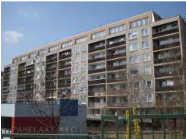
Obr. 47 Konstrukční soustava VVÚ-ETA (Zdroj: panelaky.info)
