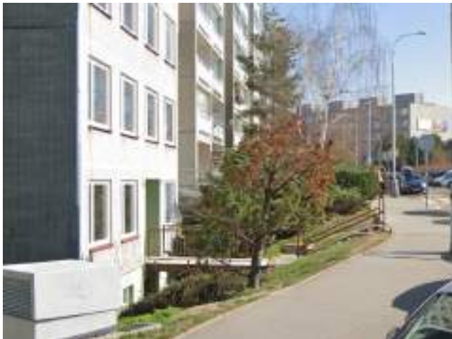
Obr. 164 Vstup do domu (Zdroj: google maps)
