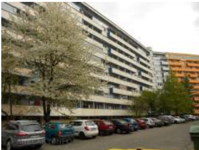
Obr. 174 Konstrukční soustava T06B (Zdroj: panelaky.info)
