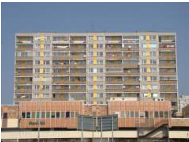
Obr. 44 Konstrukční soustava VVÚ-ETA (Zdroj: panelaky.info)
