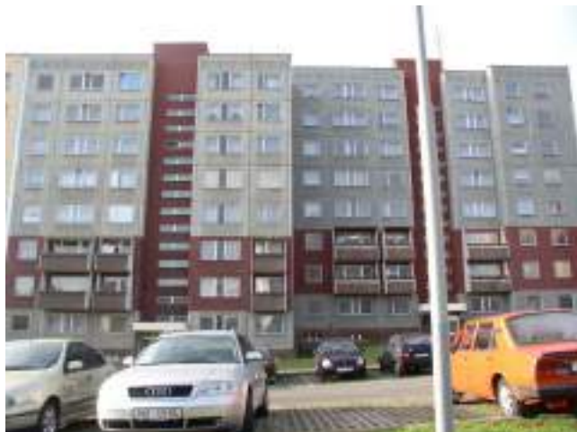
Obr. 83 Konstrukční soustava OP 1.31 (Zdroj: panelaky.info)
