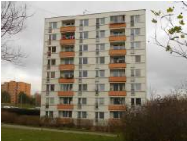
Obr. 24 Konstrukční soustava T06B - bodová sekce (Zdroj: panelaky.info)
