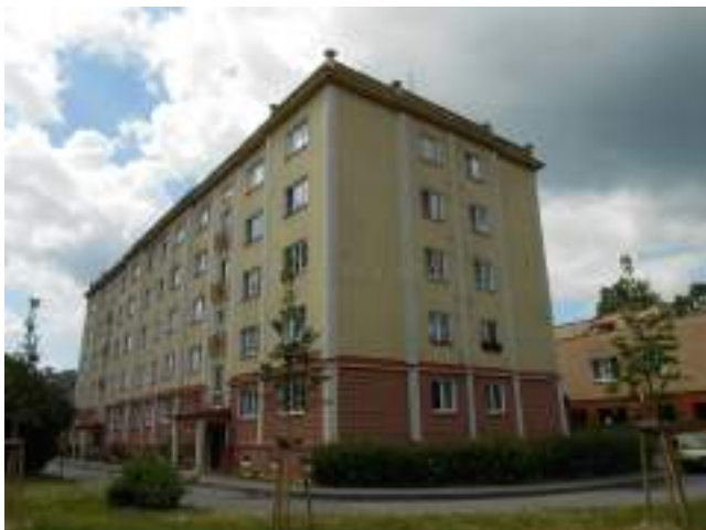
Obr. 7 Konstrukční soustava G40, Zlín - Benešovo nábřeží (Zdroj: panelaky.info)
