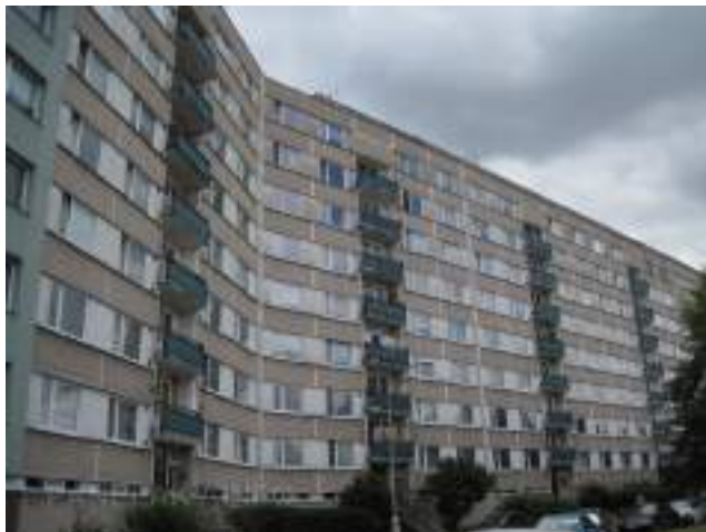
Obr. 12 Konstrukční soustava T06B (Zdroj: panelaky.info)
