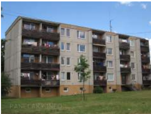
Obr. 15 Konstrukční soustava T06B (Zdroj: panelaky.info)
