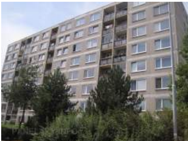
Obr. 101 Konstrukční soustava Larsen-Nielsen (Zdroj: panelaky.info)
