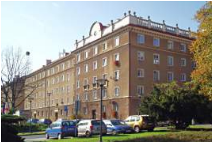
Obr. 118 Konstrukční soustava T15, ulice Alšova, Ostrava – Poruba (Zdroj: Stanislav Endel)
