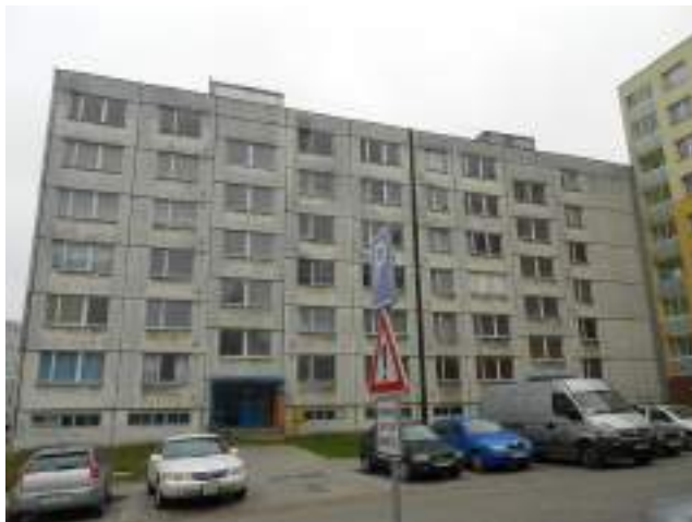
Obr. 59 Vstup do objektu (Zdroj: panelaky.info)
