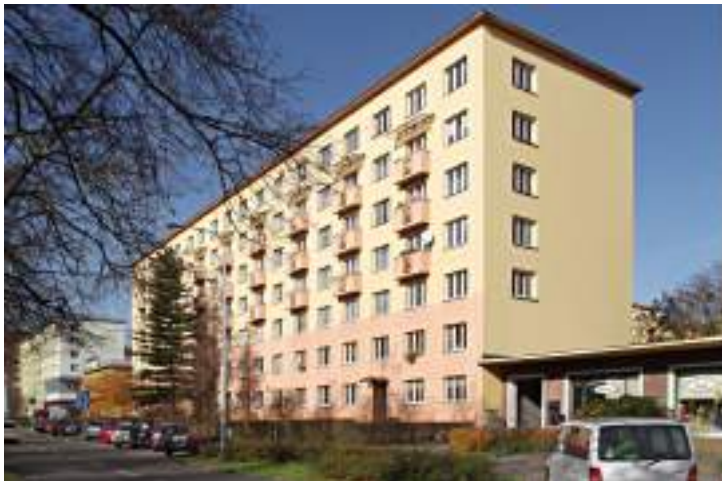
Obr. 124 Konstrukční soustava T03B-OS, Hlavní třída, Ostrava – Poruba (Zdroj: Stanislav Endel)
