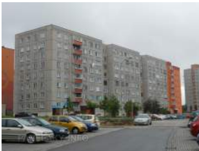
Obr. 91 Konstrukční soustava OP 1.31 (Zdroj: panelaky.info)
