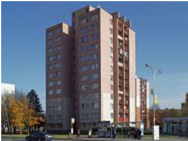
Obr. 130 Konstrukční soustava T06B-BTS, ulice 17. listopadu, Ostrava – Poruba (Zdroj: Stanislav Endel)
