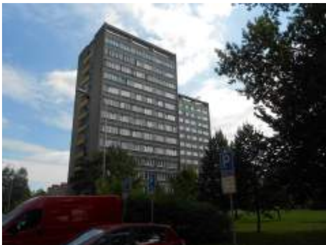
Obr. 109 Konstrukční soustava V-OS (Zdroj: panelaky.info)
