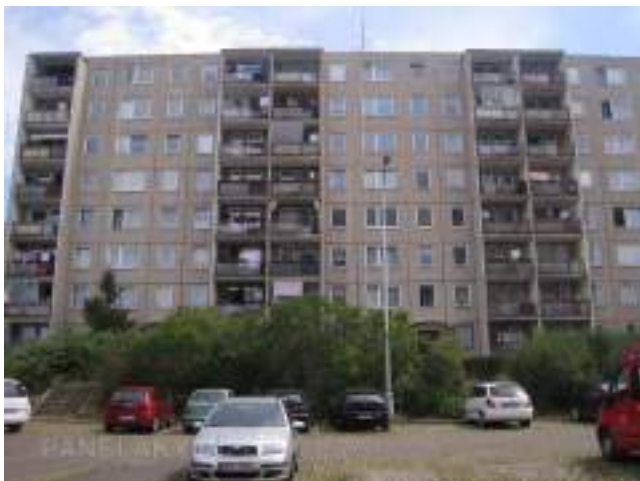
Obr. 98 Konstrukční soustava Larsen-Nielsen (Zdroj: panelaky.info)
