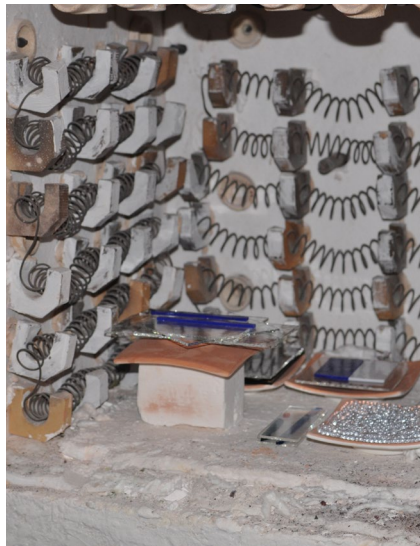
SKLÁŘSKÁ PEC NA LEHÁNÍ A SPÉKÁNÍ SKLA, POHLED DO PECE BĚHEM PROCESU
