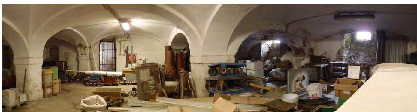
klenuté prostory v přízemí budovy A
