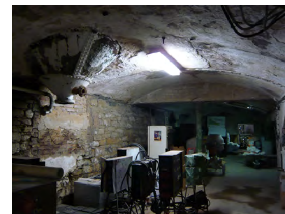
interier přízemí budovy A
