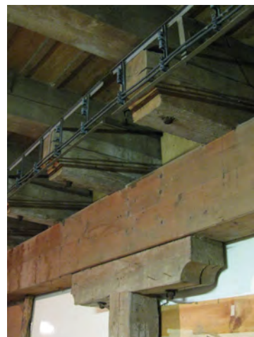
stropní trámy 2.NP budovy B
