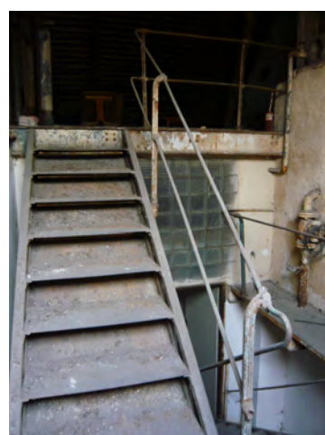
schodiště v budově B, bude obnoveno a ponecháno
