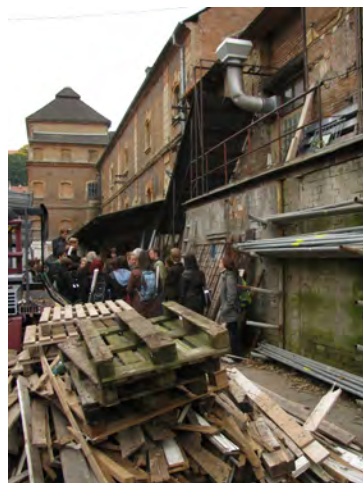
severní pohled na východní fasádu
