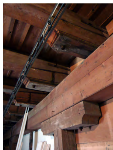
trámový strop v 3.NP budovy A
