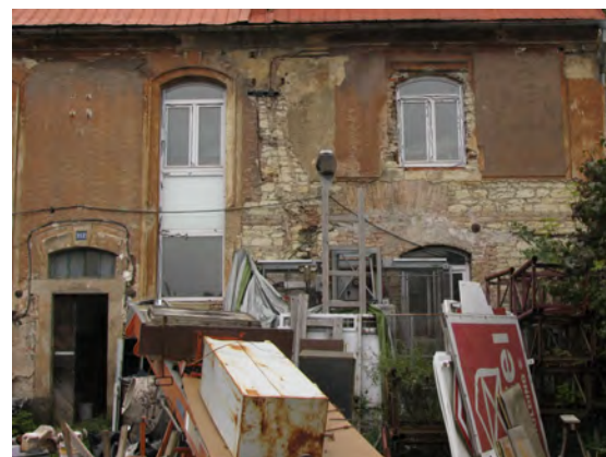
východní pohled na budovu B
