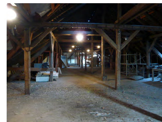
krov budovy A
