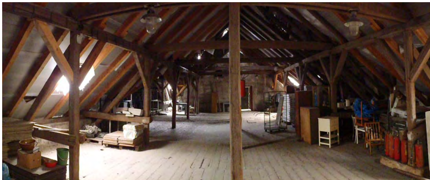
pohled do krovu budovy A
