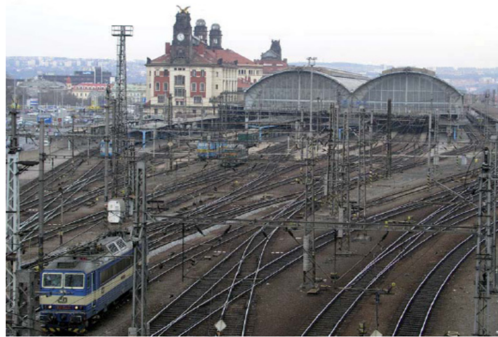
KOLEJIŠTĚ SMĚR HLAVNÍ NÁDRAŽÍ
