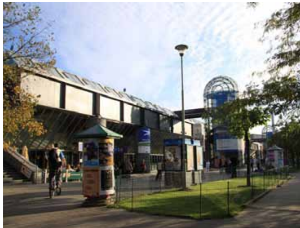
ODBAVOVACÍ HALA Z VRCHLICKÉHO SADŮ
