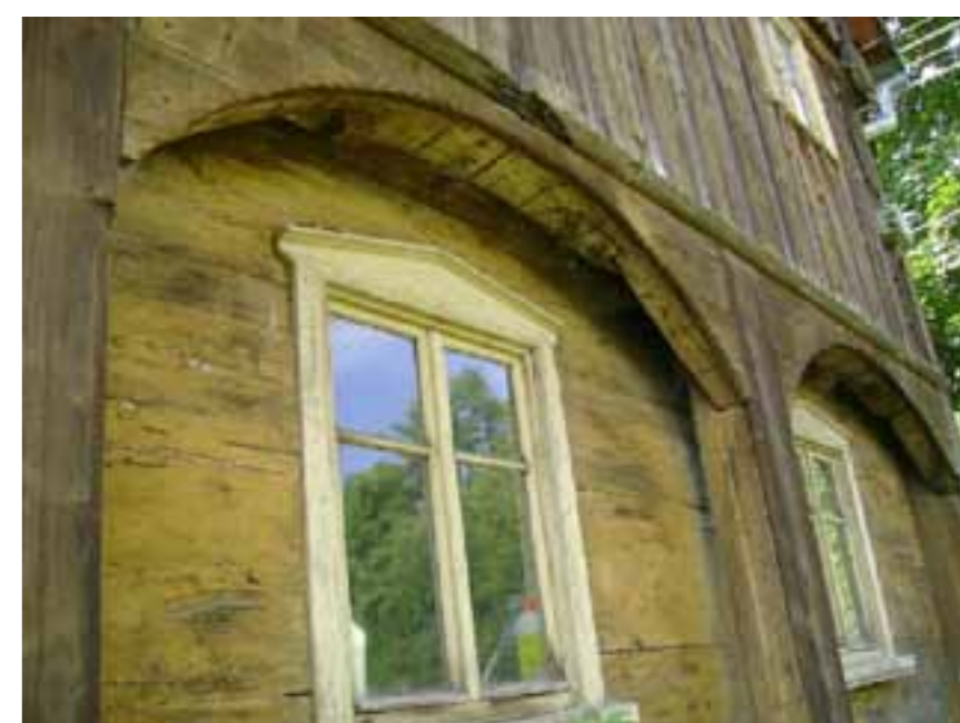
detail konstrukce podstávky
