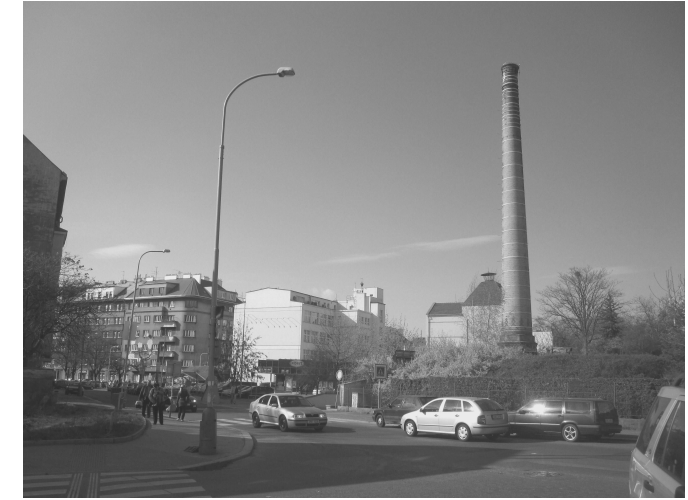
TOVÁRNA JIRÁSKO, SUŠÁRNA, KOMÍN
