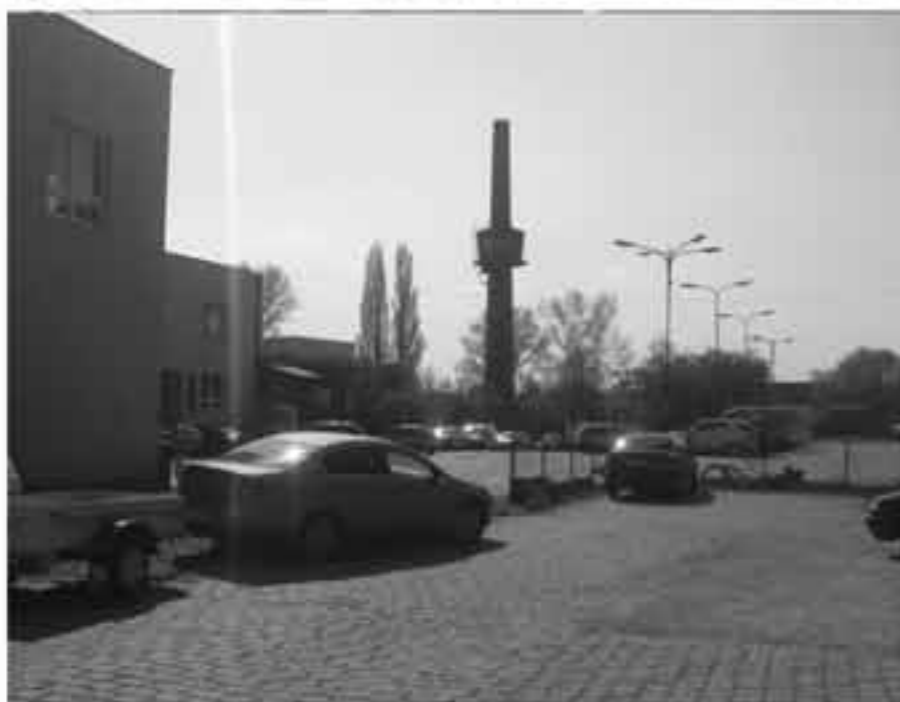
Komín s vodojemem
