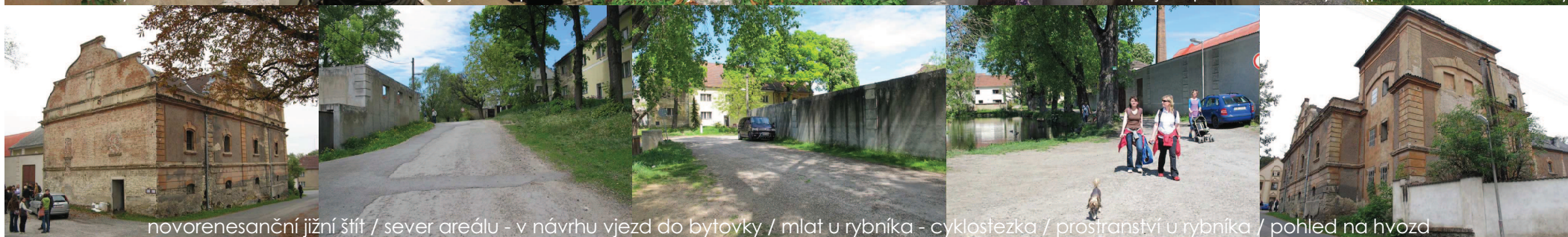
detail fasády / interiér zdevastované budovy / jižní sklepní okno / interiér jižní části / schodiště hvozdů / stavido, místo napojení původního mlýna (pouze zmínky o něm)
