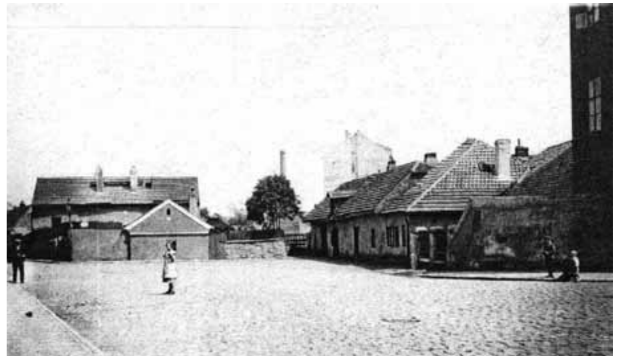
Holešovice - Partyzánská ulice (foto kolem 1915)
