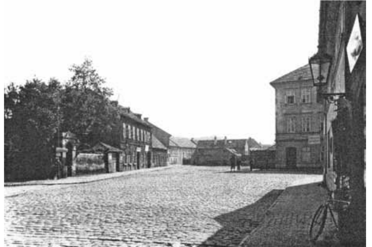
Holešovice - Partyzánská ulice (foto kolem 1940)
