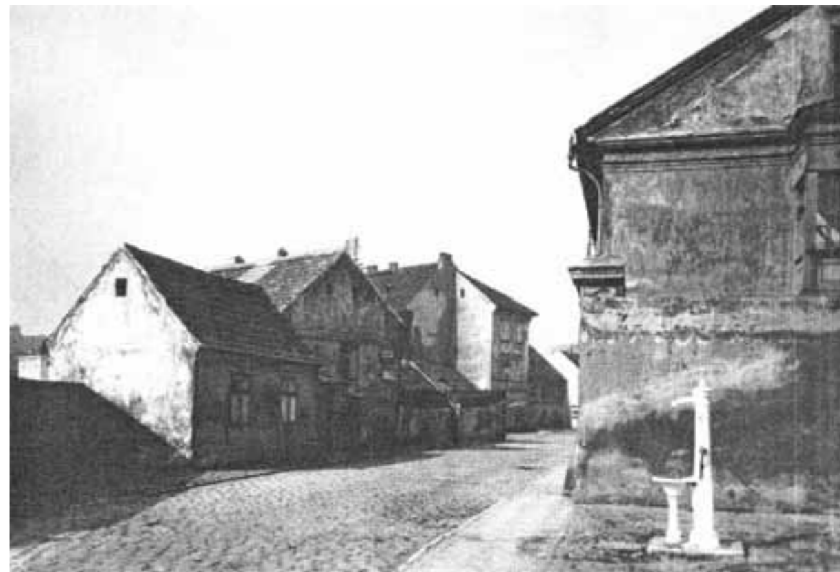
Holešovice - Partyzánská ulice (foto kolem 1940)
