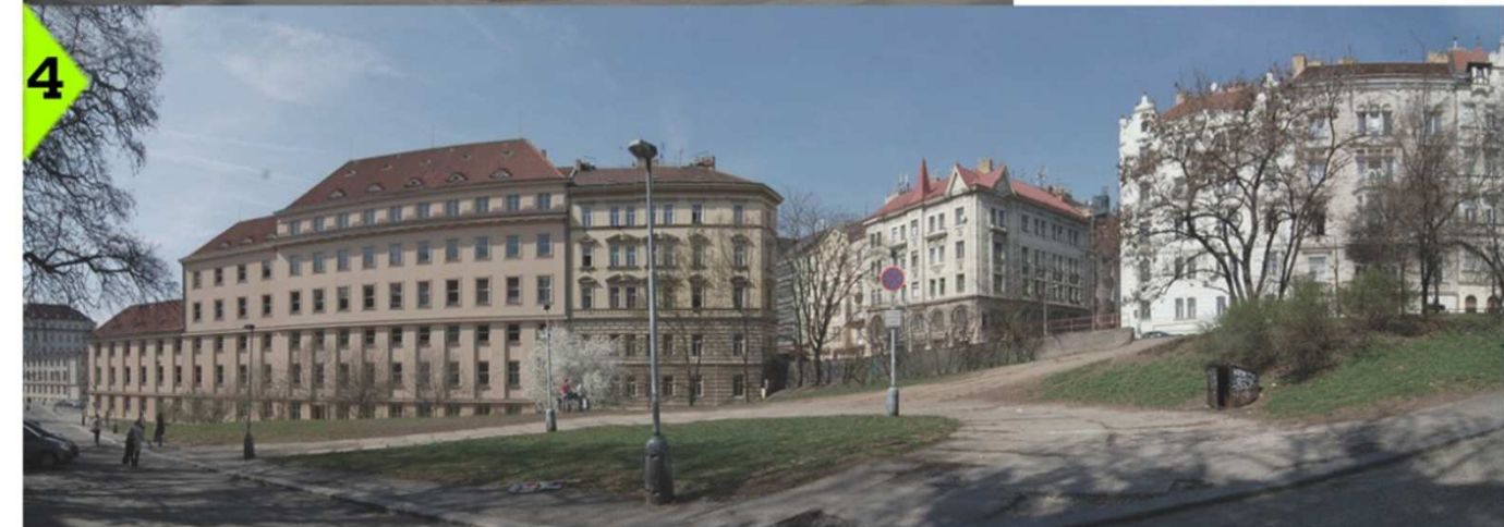
4. Celkový pohled na pozemek s jihovýchodní strany.
