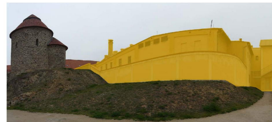
Bourané budovy - měřítkové neúměrné lokality, či pozdější nevhodný zásah.
