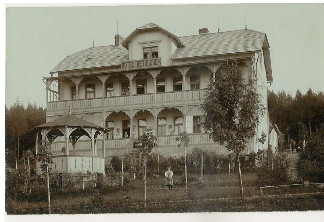
PŮVODNÍ BUDOVA - DOBOVÁ FOTOGRAFIE
