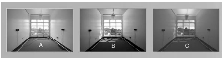
Princip napojení elektrochromních oken s vnitřním osvětlovacím systémem. (A) při zatažené obloze, jsou elektro okna na maximální úrovni přenosu a světla jsou na minimální výkon. (B) Když slunce vyjde zpoza mraků, okna tmavnou a řídí solární tepelné zisky a oslnění. (C) Asi po pěti minutách slunečního svitu, jsou elektro okna plně ztemnělé a výkon osvětlovacího zařízení se mírně zvýšil.
