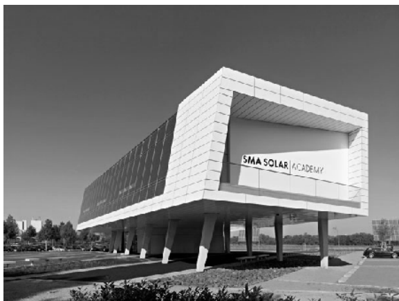
Užití fotovoltaických panelů v praxi – školící centrum SMA zdroj: www.asb-portal.cz
