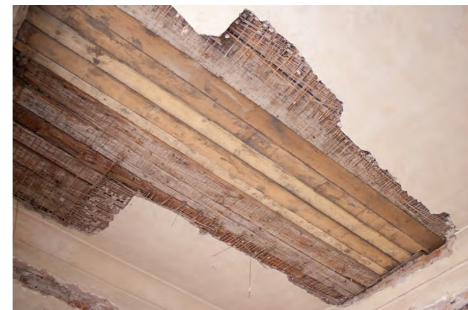
Obj. A, 1.10: „Typlový strop“ tvořen na sraz kladenými trámy, spojovanými vzájemně kolíky
