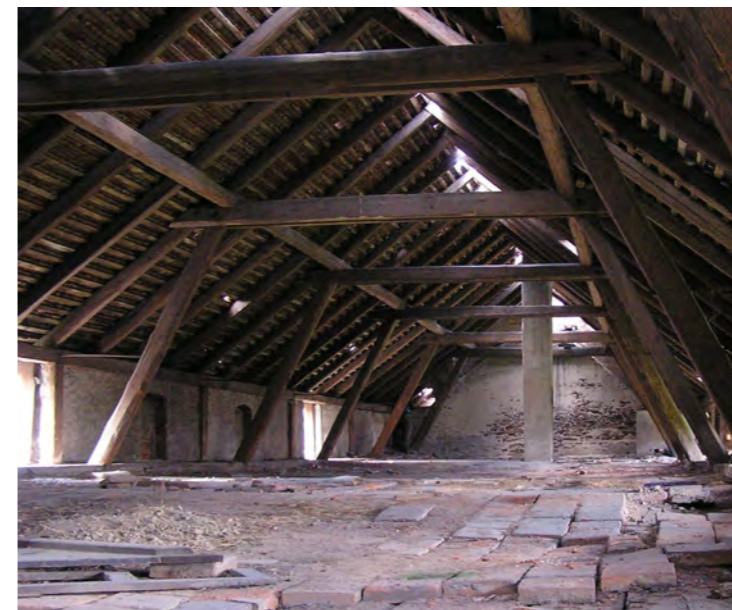
Obj. B, krov nad stájemi - vaznicový s šikmými sloupy bez pásků s kleštinami. Dále vysoká nadezdávka a přečnávající zdobené krokve. Dendrochronologicky datováno na rok kácení dřeva 1883.
