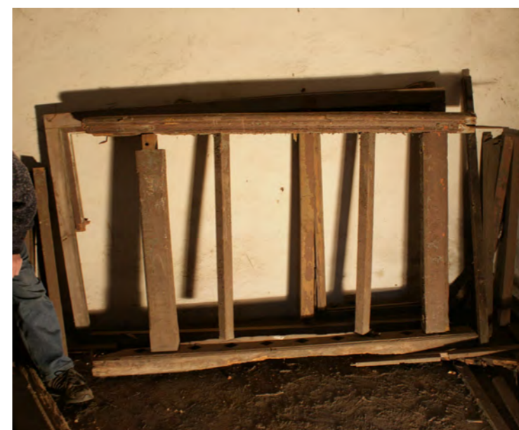
Obj. A, 1.10: Odstraněné zábradlí patřící schodišti v patře. Jedná se typické klasicistní zábradlí s nakoso natáčenými čtyřbokými tyčemi. (Dle zaměření je provedena rekonstrukce ve vizualizaci)
