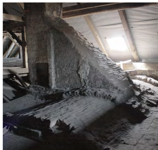
Obj. A, krov dvorního křídla - mohutný dymník nad někdejší černou kuchyní v patře, zrušena 1803-5 a ústí dymníku zaklenuto.
