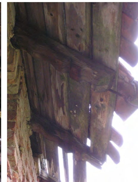
Obj. B, krov nad stájemi - vaznicový s šikmými sloupy bez pásků s kleštinami. Dále vysoká nadezdávka a přečnávající zdobené krokve. Dendrochronologicky datováno na rok kácení dřeva 1883.
