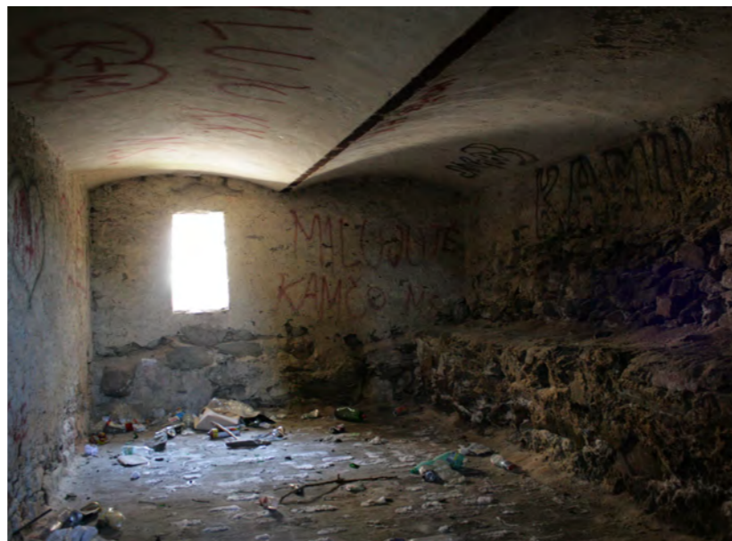
Obj. B, sklep: obnažený základ
