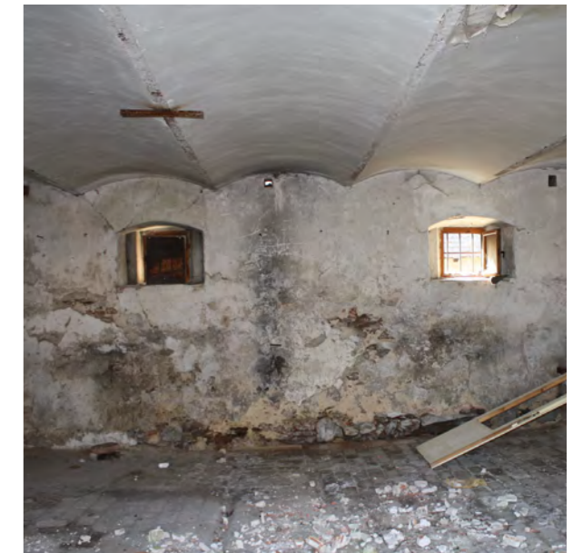
Obj. B, P.05 - typická stájová klenba stavební povolení 1920
