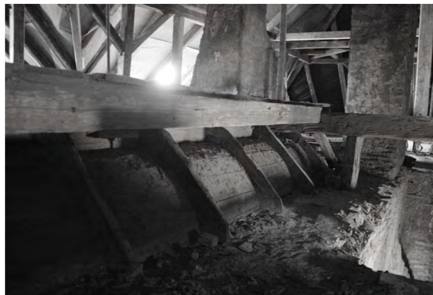
Obj. A, 1.01: Iluzivní klenba budovaná v letech 1803-5. Omítnutý prkenný podhled je nesen příčnými trámy umístěnými pod vaznými trámy. Tyto trámy jsou ještě zavěšeny na táhlech z krovu. Klenbový (nebo spíše fabionový) tvar je tvořen vytvarovanými širokými fošnami, tvořícími nosníky přibitých prken.
