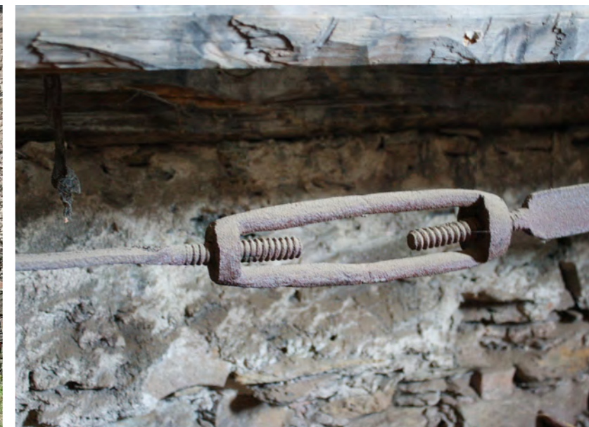
Obj. A, jižní křídlo, krov: oboustranný šroubový napínací spoj táhla (2. pol. 19. stol)
