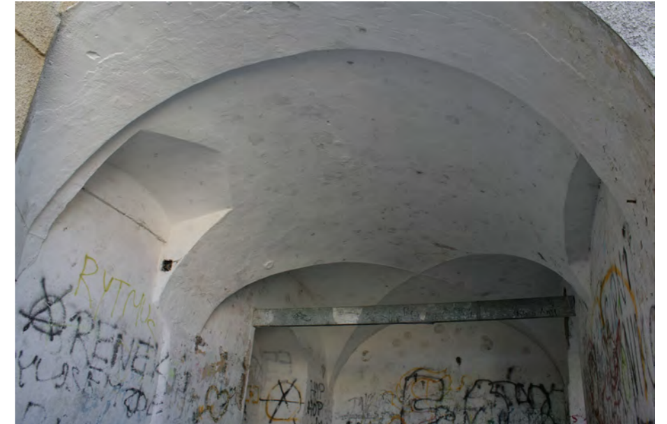
Klenba loubí - jedná se o barokní stlačenou valenou klenbu s protínavými výsečemi hlavních oblouků loubí a přibokými výsečemi někdejších oken.
