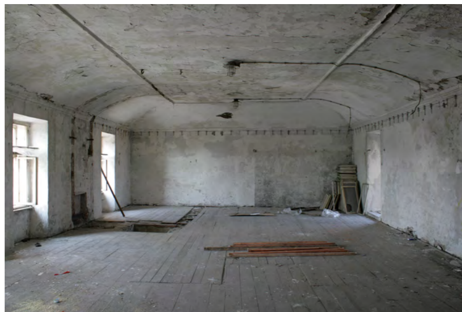
Obj. A, 1.01: Iluzivní klenba budovaná v letech 1803-5. Omítnutý prkenný podhled je nesen příčnými trámy umístěnými pod vaznými trámy. Tyto trámy jsou ještě zavěšeny na táhlech z krovu. Klenbový (nebo spíše fabionový) tvar je tvořen vytvarovanými širokými fošnami, tvořícími nosníky přibitých prken.
