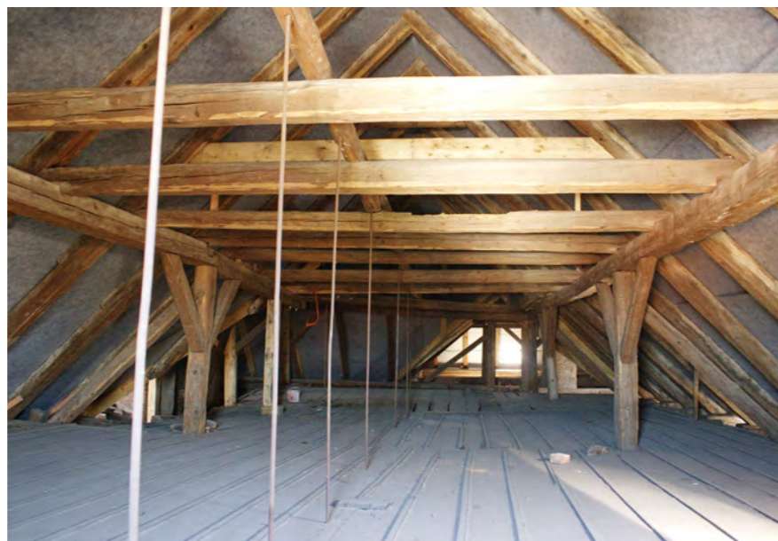
Obj. A, severní křídlo - hambalkový krov se dvěma stojatými stolicemi se vzpěrami. Táhlá vyvěšují trámy falešné klenby sálu. Dendrochronologicky datováno - 1833.
