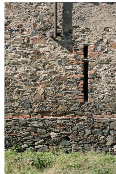
Obj. B, jižní fasáda: lomové (příp. sbírané) zdivo se na objektu objevuje v různých etapách.
