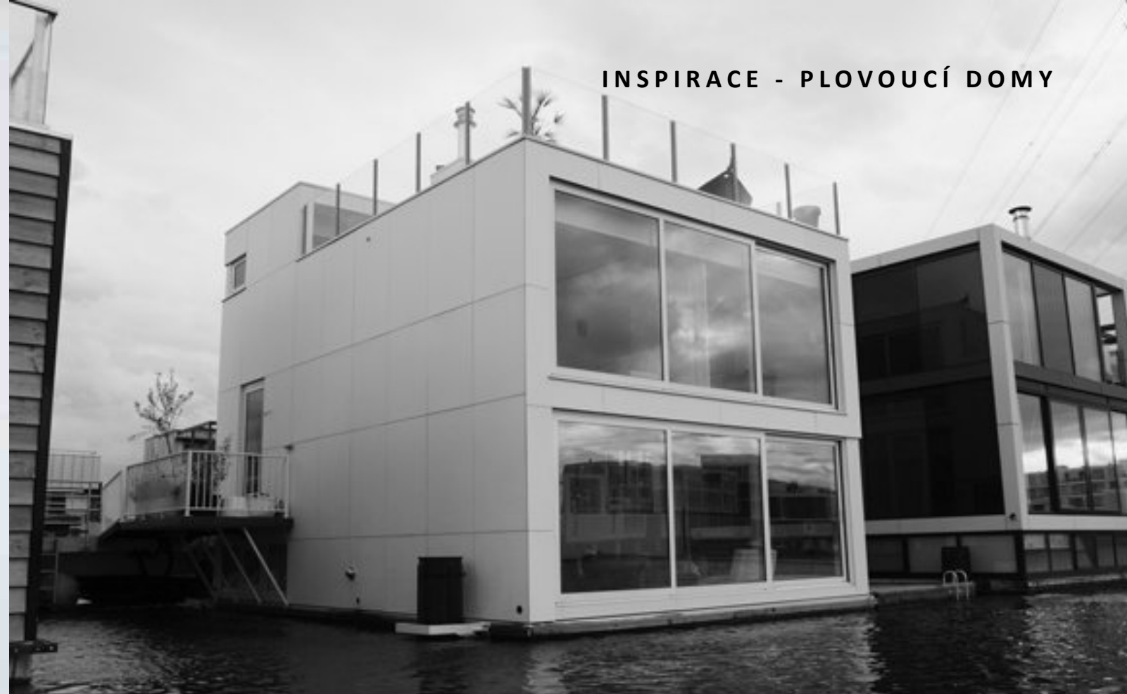
Floating homes - Nizozemí
