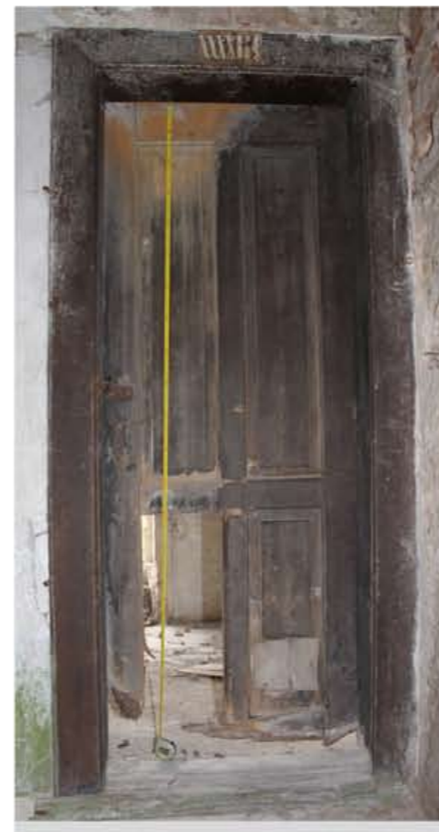
2.01D5 Dřevěný stropní poklop, sbíjená kce, dževěná jednoduchá zárubeň. Předpoklad : zbudovaný během konverze v roce 1942
