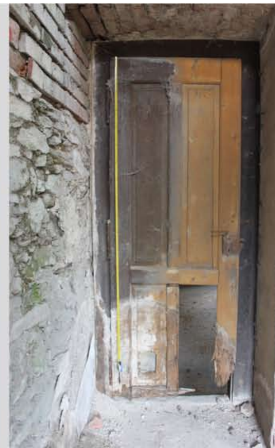
2.01D2 Dřevěná rámová konstrukce, jednokřídlá, rovné nadpraží, dveřní křídlo – 4 pole Kování: zámek- novodobý vnější krabicový, klika-jednoduchá páková konická zaoblená, zapuštěné závěsy- s kuličkami na kuželových koncích Povrchová úprava: tm.hnědý nátěr, šednoucí dřevo Předpoklad : tvary závěsů odpovídají 2/2 19.stol, původně zapuštěné závěsy- dveře byly vstupní do významných prostor varny, proto použity historizující zdobné tvary závěsů
