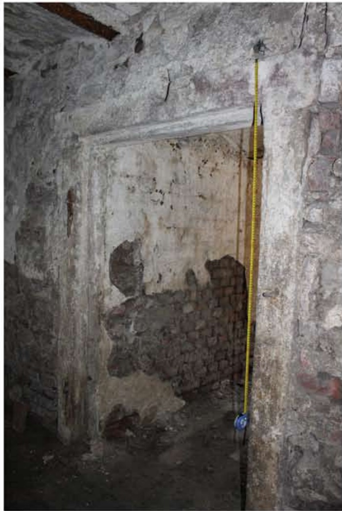
1.01D1, 1.01D2 Dveřní otvor do průchodu ke starému ležáckému sklepu 0.09, zárubeň z kamených bloků Kování : dochovaná je dvojice závěsů na levé straně, stěžež s opěrkou sou kotveny v kamenném ostění, závěsy zadlabané (2/2 19.stol)
