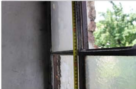
2.0101, 2.0102, 2.0103 Segmentové jednoduché okno neotvíravé, kovové, jednoduché zasklení, dodatečně přidána druhá vrstva skla na tmel, 8mi tabulková, subtilní ocelové úhelníkové profily (zasklívací profily) s tmelovým zasklením, poutec ve vrchní části, segmentové sluneční členění vrchní části do 9tabulek Ostění cihlné, vyzdívka parapetu z dutých cihel s drážkou, neomítané. Předpoklad : vzhledem k původní technologii prostor výškově předělen patrně v při konverzi 1942, okna probíhala v kci podlahy, proto provedena zazdívka parapetů
