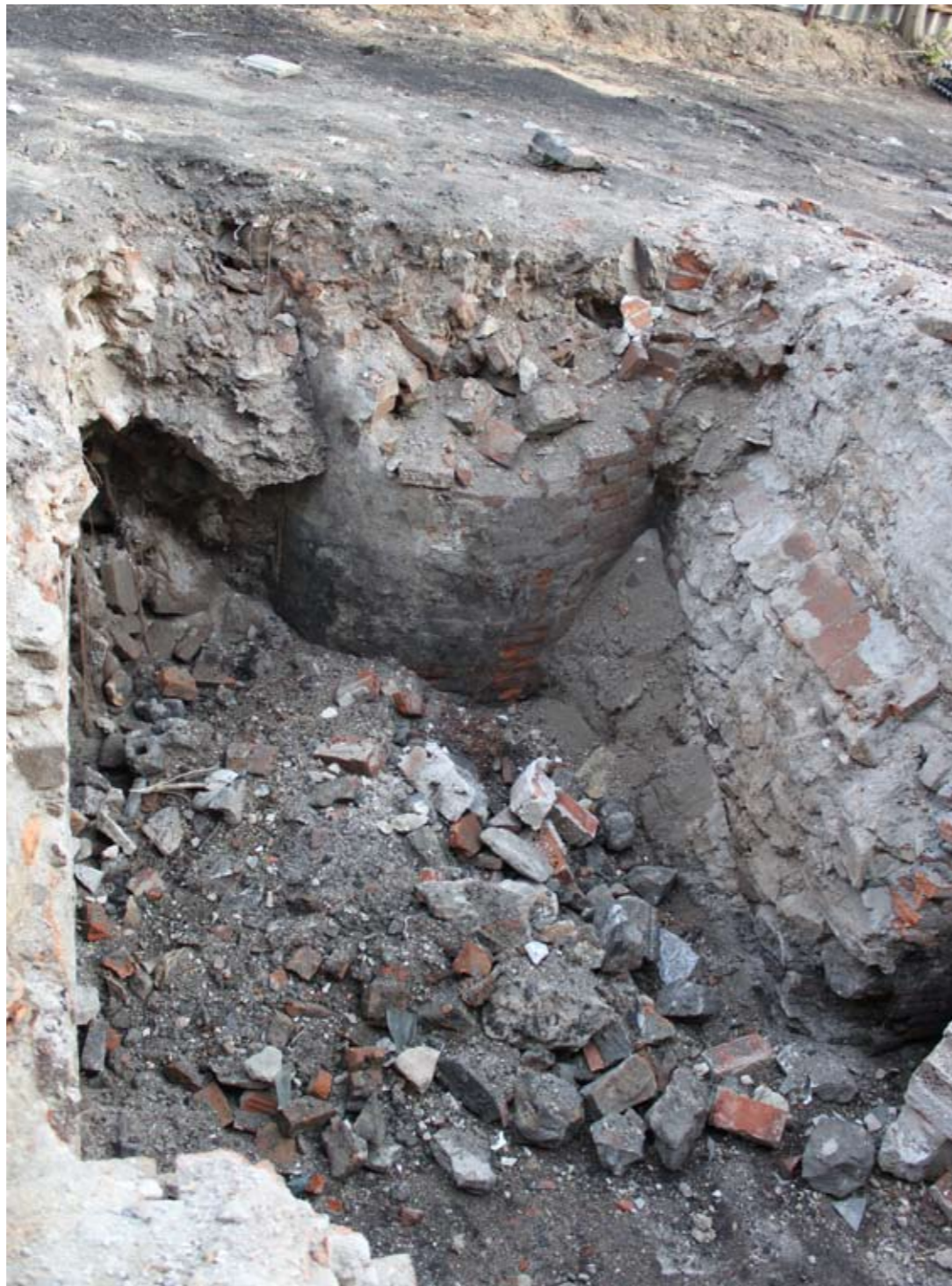
Odhalená část točitého schodiště v úrovni přízemí
