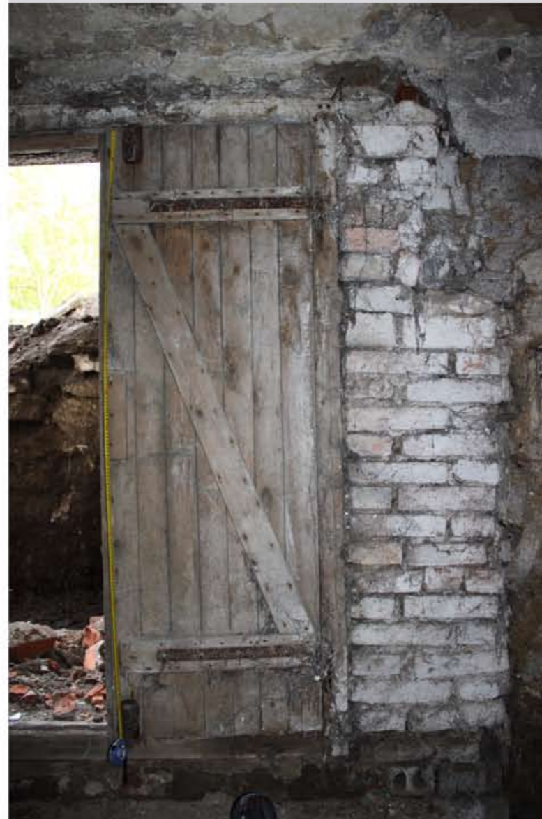
1.01D2 Dvoukřídlé svlakové dveře, sbíjené, z měkkého dřeva, kování je z období po roce 1942, vnější závěsy, tvořící stěžež s opěrkou, jsou kotveny do zárubně z měkkého dřeva, dveřní křídla jsou nesena ocelovými pásky a upevněna šrouby se čtyřhranými matkami
