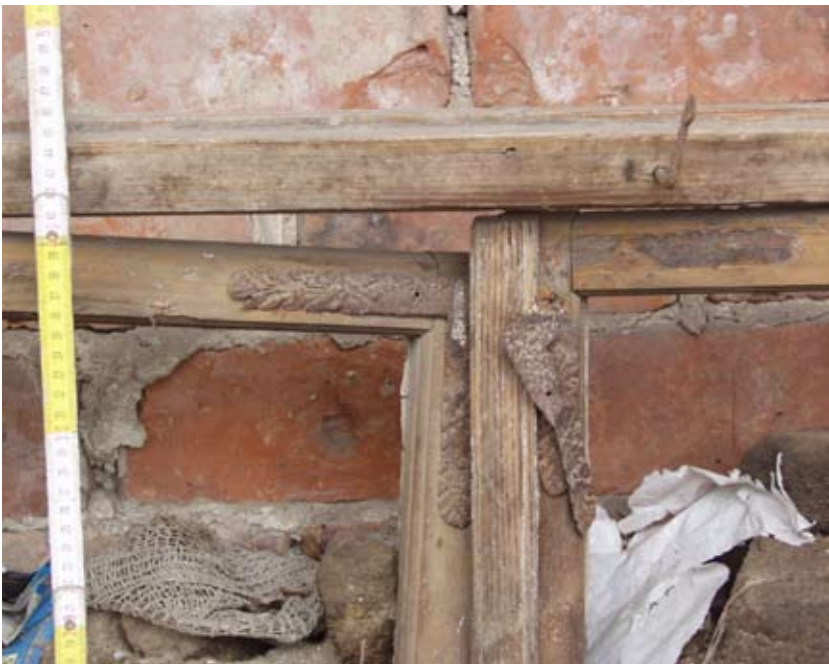
Detail barokního kování okna 1.0901
