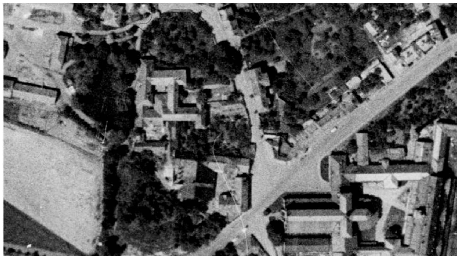
Letecká fotografie z doby před zbouráním většiny budovy hvozdu kvůli narovnání komunikace ulice Vítězné.
