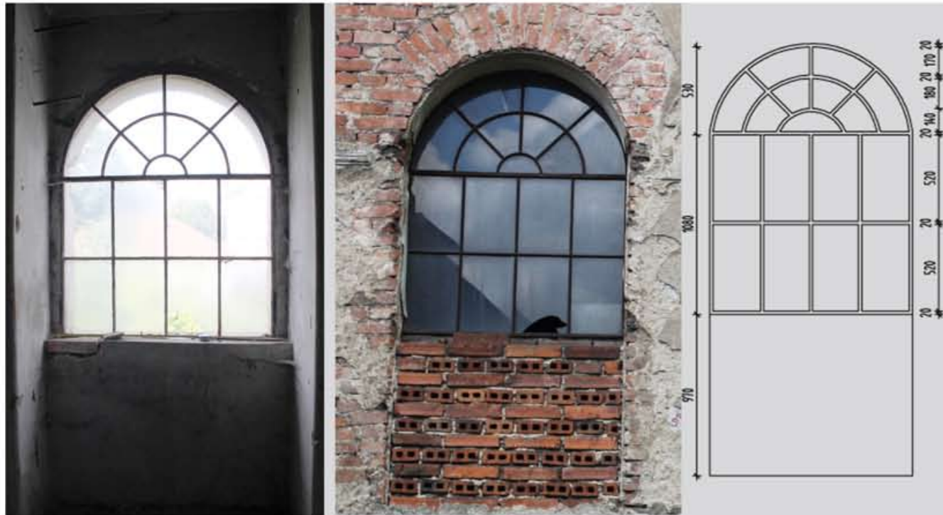
2.0101, 2.0102, 2.0103 Segmentové jednoduché okno neotvíravé, kovové, jednoduché zasklení, dodatečně přidána druhá vrstva skla na tmel, 8mi tabulková, subtilní ocelové úhelníkové profily (zasklívací profily) s tmelovým zasklením, poutec ve vrchní části, segmentové sluneční členění vrchní části do 9tabulek Ostění cihlné, vyzdívka parapetu z dutých cihel s drážkou, neomítané. Předpoklad : vzhledem k původní technologii prostor výškově předělen patrně v při konverzi 1942, okna probíhala v kci podlahy, proto provedena zazdívka parapetů
