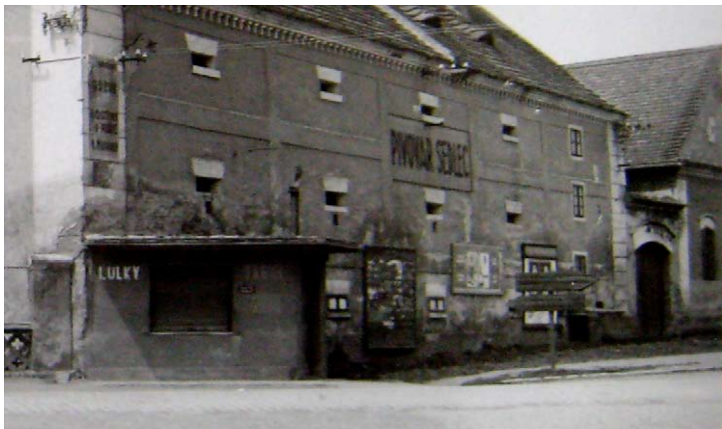
Dobová fotografie, pohledy na východní fasádu sýpky
