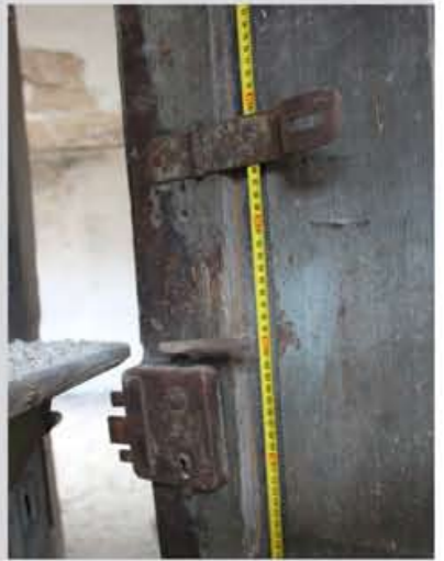
2.01D3 Dřevěná rámová konstrukce, jednokřídlá, rovné nadpraží, dveřní křídlo – 4 pole Kování: zámek- novodobý vnější krabicový, klika-jednoduchá páková konická zaoblená, zapuštěné závěsy- s kuličkami na kuželových koncích Povrchová úprava: šedý nátěr Předpoklad : tvary závěsů odpovídají 2/2 19.stol, původně zapuštěné závěsy- dveře byly vstupní do významných prostor varny, proto použity historizující zdobné tvary závěsů
