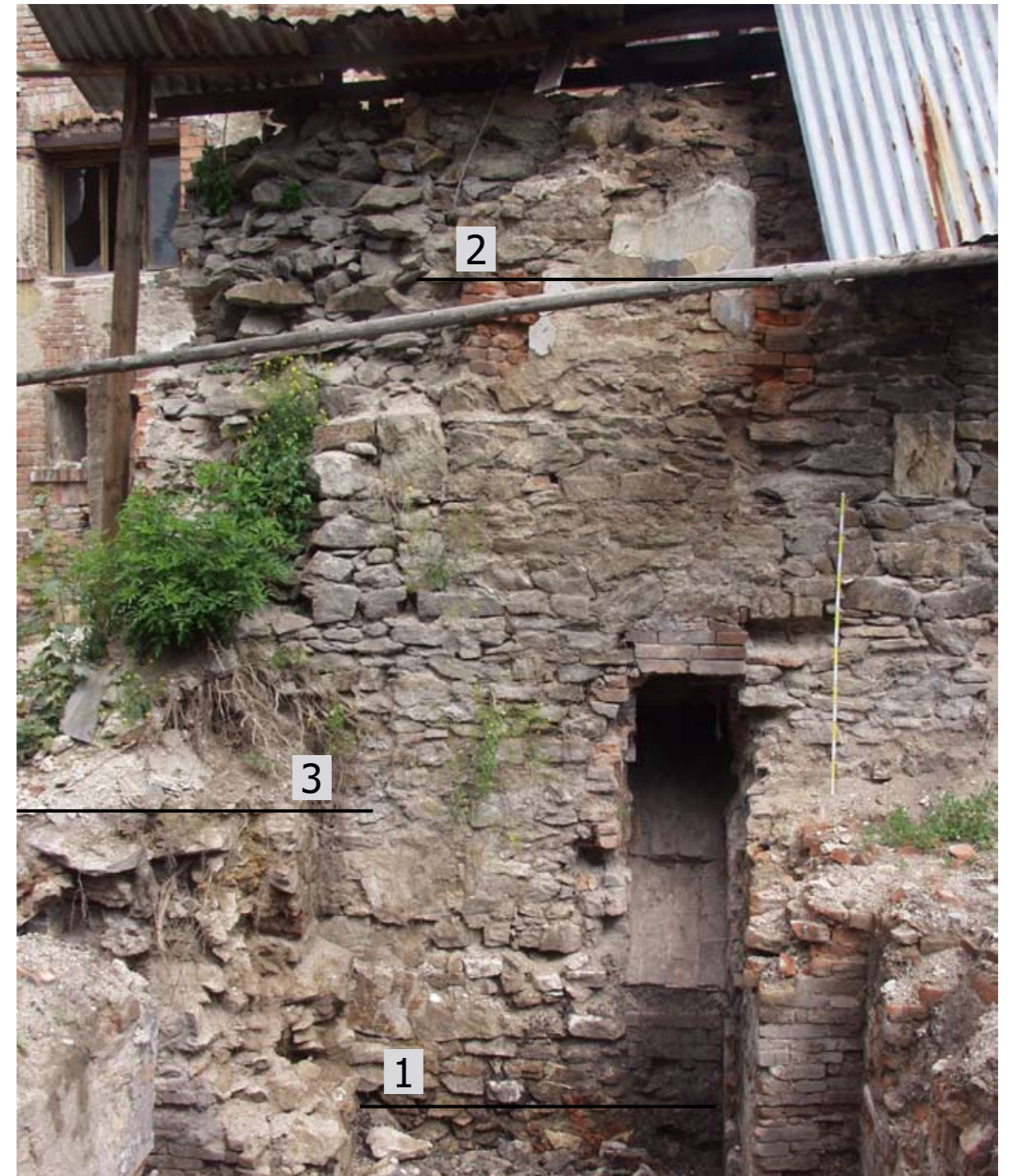
Odvozené přibližné výškové úrovně podlah: 1. Podlaha gotického přízemí 2. Podlaha gotického 1. patra 3. Úroveň terénu
