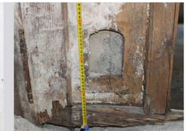
2.01D2 Dřevěná rámová konstrukce, jednokřídlá, rovné nadpraží, dveřní křídlo – 4 pole Kování: zámek- novodobý vnější krabicový, klika-jednoduchá páková konická zaoblená, zapuštěné závěsy- s kuličkami na kuželových koncích Povrchová úprava: tm.hnědý nátěr, šednoucí dřevo Předpoklad : tvary závěsů odpovídají 2/2 19.stol, původně zapuštěné závěsy- dveře byly vstupní do významných prostor varny, proto použity historizující zdobné tvary závěsů
