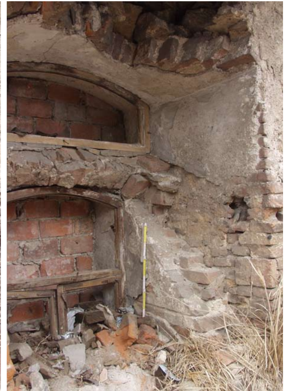
Detail ostění náběhu větracího otvoru zřízeného při prohloubení přízemí
