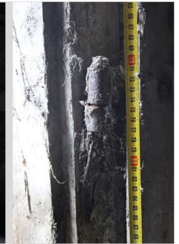
1.01D2 Dvoukřídlé svlakové dveře, sbíjené, z měkkého dřeva, kování je z období po roce 1942, vnější závěsy, tvořící stěžež s opěrkou, jsou kotveny do zárubně z měkkého dřeva, dveřní křídla jsou nesena ocelovými pásky a upevněna šrouby se čtyřhranými matkami
