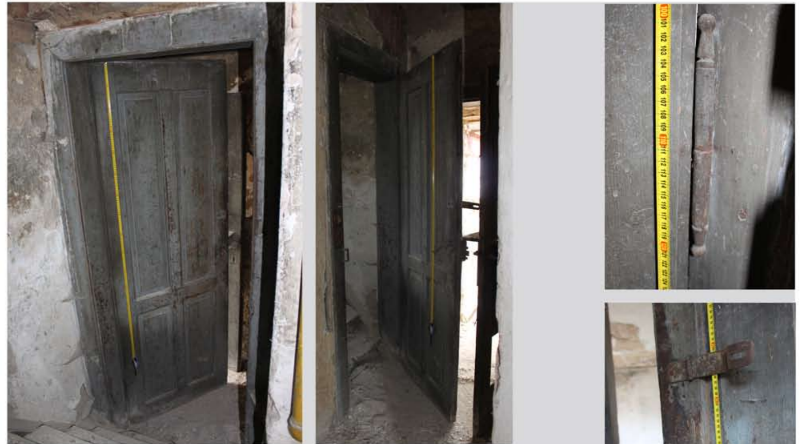
2.01D3 Dřevěná rámová konstrukce, jednokřídlá, rovné nadpraží, dveřní křídlo – 4 pole Kování: zámek- novodobý vnější krabicový, klika-jednoduchá páková konická zaoblená, zapuštěné závěsy- s kuličkami na kuželových koncích Povrchová úprava: šedý nátěr Předpoklad : tvary závěsů odpovídají 2/2 19.stol, původně zapuštěné závěsy- dveře byly vstupní do významných prostor varny, proto použity historizující zdobné tvary závěsů
