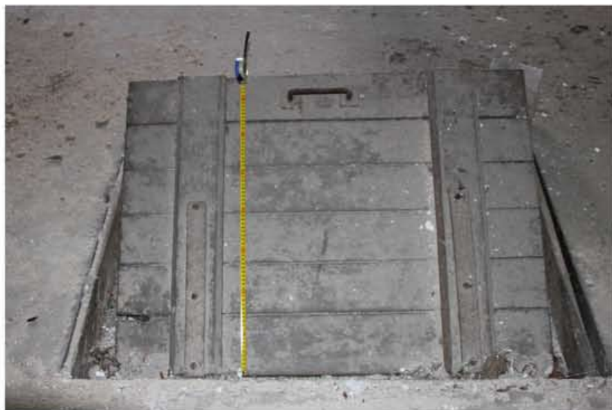
2.01D5 Dřevěný stropní poklop, sbíjená kce, dževěná jednoduchá zárubeň. Předpoklad : zbudovaný během konverze v roce 1942
