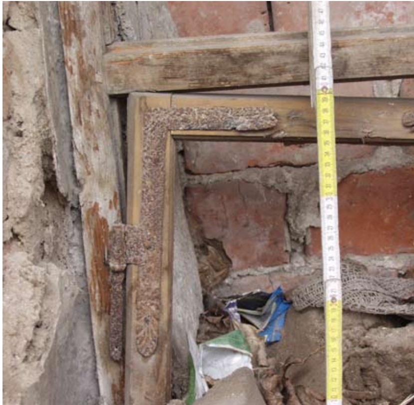
Detail barokního kování okna 1.0901
