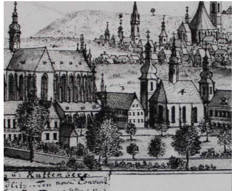
Na této vedutě je sýpka se správným patrováním i tvarem střechy, tvar oken však neodpovídá
