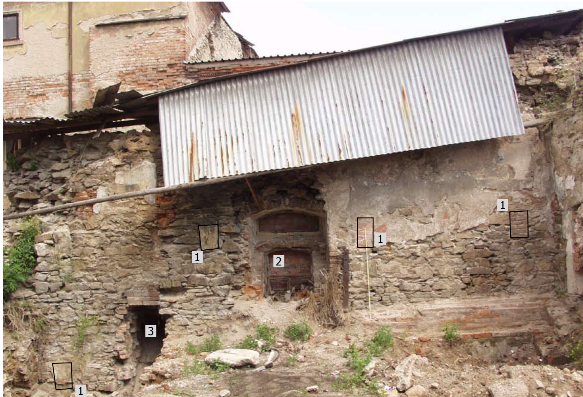
Torzo severní stěny sýpky 1.09
