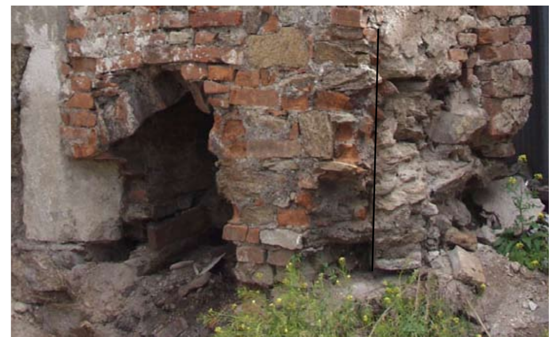
Pozůstatek protilehlé hrany špalety gotického otvoru v přízemí
