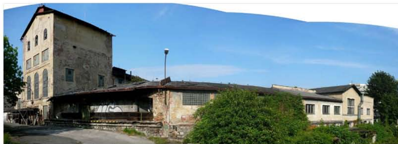
RAMENO BÝVALÉHO HLAVNÍHO VÝROBNÍHO BLOKU - OBJEKTY SKLADŮ A ADMINISTRATIVY
