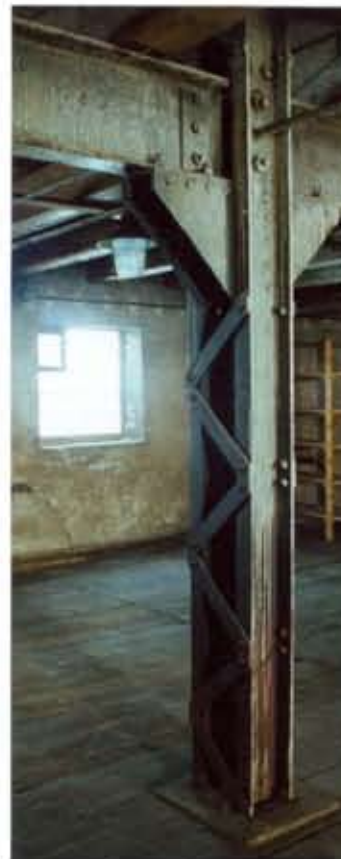
SKLAD LIHU (BLOK B)
