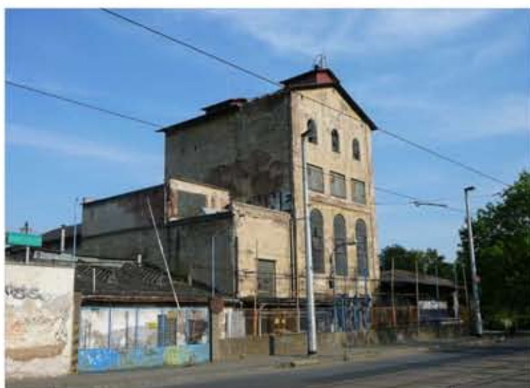
HLAVNÍ OBJEKT RAFINERIE LIHU - POHLED OD VJEZDU DO AREÁLU
