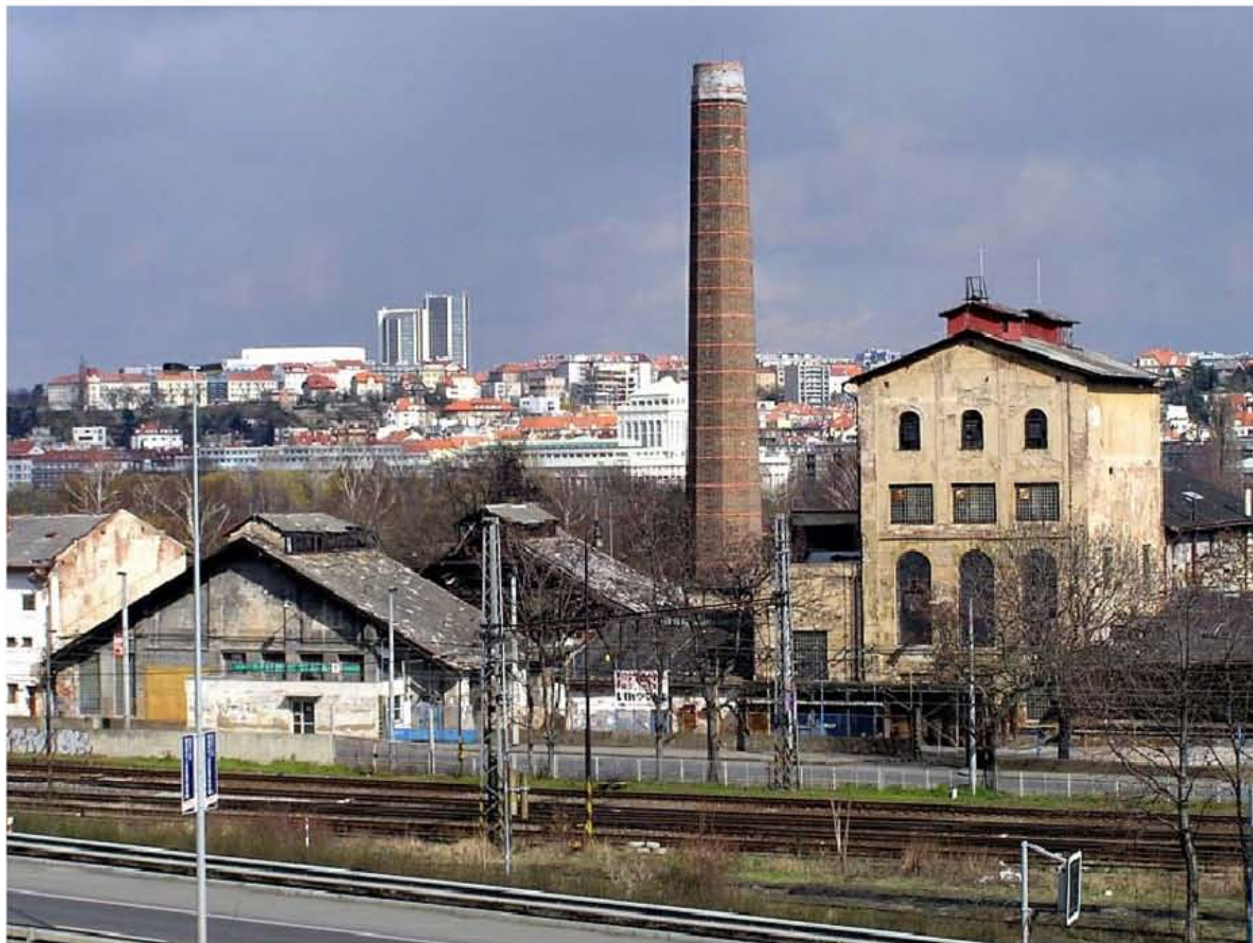
POHLED NA LIHOVAR - OBJEKT POTAŠOVNY (se zřícenou střešní konstrukcí), KOMÍN A BUDOVA RAFINERIE (varná síň)
