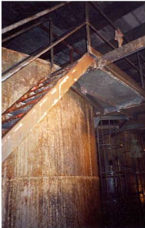
ŠUTERÉN SKLADŮ - HLAVNÍ BLOK VÝROBY (A)
