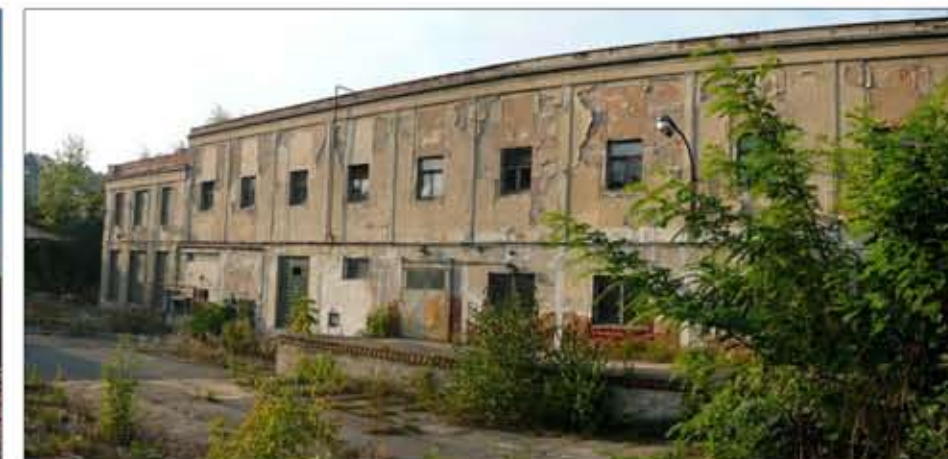
SOUČASNÝ STAV OBJEKTU - POHLEDY ZE DVORA AREÁLU
