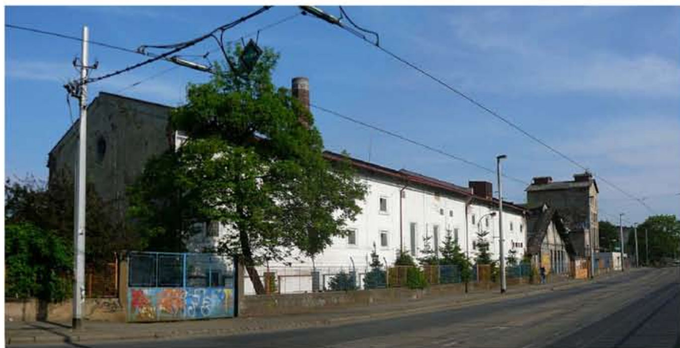
POHLED Z ULICE NÁDRAŽNÍ OD SEVERU NA SKLAD LIHU - SOUČÁST VÝROBNÍHO BLOKU OCTA
