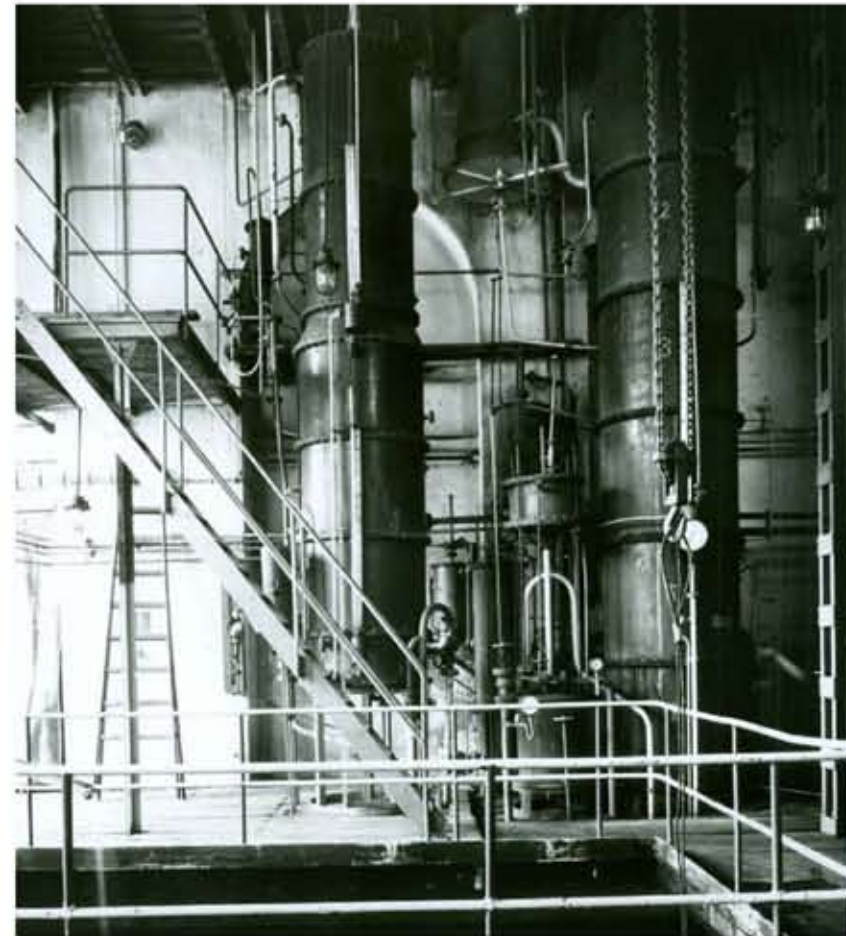
INTERIÉR RAFINERIE (varná síň) PŘED UKONČENÍM PROVOZU
