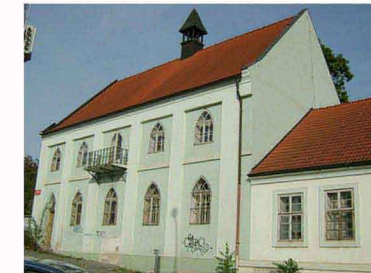
POPELÁŘKA původně vinice s lisem, obytná budova (pol. 18.stol.)
