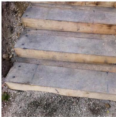
VYROVNÁVACÍ SCHODIŠTĚ V AREÁLU JSOU NAVRŽENA Z DŘEVĚNÝCH TRÁMŮ. CESTY NA SVAHU PŘI MOZARTOVĚ ULICI JSOU PAK ŘEŠENY JAKO MLATOVÉ.
