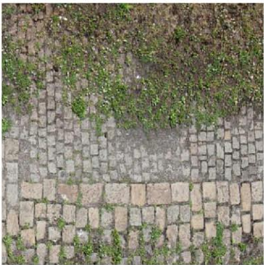
RŮZNÉ VELKÁ ŽULOVÁ DLAŽBA Kladená více směry (podle směru chodníku) a kladená se širokou spárou pro prorůstání trávy a bude bez obrub. Použita bude uvnitř rokle.
