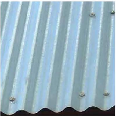
JAKO POSLEDNÍ FASÁDNÍ MATERIÁL VILADOMŮ JE NAVRŽEN OBKLAD Z VLNITÉHO PLECHU UMÍSTĚNÉHO VODOROVNĚ.
