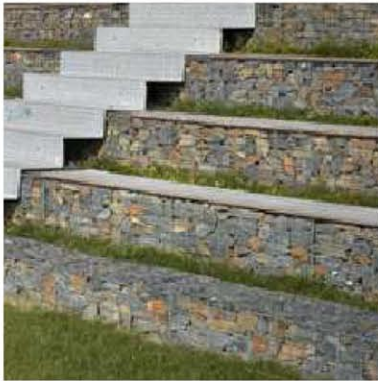
AMFITEÁTR JAKO CELEK JE VYTVOŘEN Z GABIONŮ, SEDACÍ PLOCHA Z MODŘÍNOVÝCH PRKEN A PŘÍSTUPOVÁ SCHODIŠTĚ Z OHÝBANÉHO POZINKOVANÉHO SLZIČKOVÉHO PLECHU.
