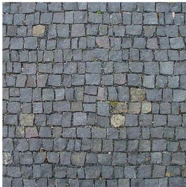
DROBNÁ ŽULOVÁ DLAŽBA S MINIMÁLNÍ SPÁROU BUDE POLOŽENA JAKO POVRCH CHODNÍKŮ.
