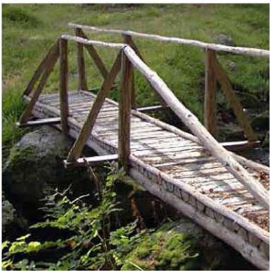
LÁVKY (MŮSTKY) PŘES OBNOVENÝ ÚDOLNÍ POTOK JSOU VYTVOŘENY Z DŘEVĚNÝCH TRÁMKŮ A KULATINY.
