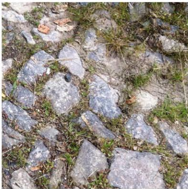
NEPRAVIDELNÁ ŽULOVÁ DLAŽBA, KTERÁ PRORŮSTÁ TRÁVOU, JE TRADIČNÍ PRO OKRAJ ULIC V CELÉ ČTVRTI. V NÁVRHU BUDE POUŽIT JAKO PLOCHA ZÁLIVŮ PODÉLNÝCH PARKOVACÍCH STÁNÍ.
