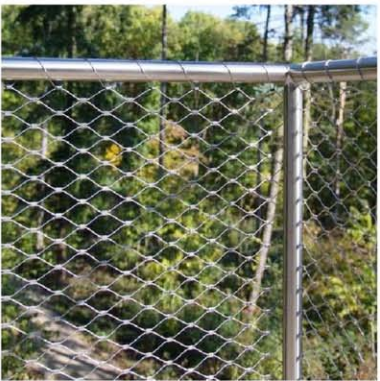
VEŠKERÉ ZÁBRADLÍ A PLOTY JSOU VYTVOŘENY SPOJENÍM NEREZOVÝCH OCELOVÝCH TRUBEK A NEREZOVÝCH SÍTÍ.
