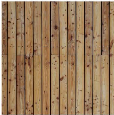
JEDEN Z NAVRŽENÝCH POVRCHŮ FASÁD VILADOMŮ JE SVISLÝ MODŘÍNOVÝ PRKENNÝ OBKLAD.
