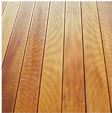
MODŘÍNOVÁ PROFILOVANÁ PRKNA BUDOU TVOŘIT VŠECHNY PLOCHY TERAS, LODŽÍ I U KAVÁRNY, KLUBOVEN I BYTŮ.
