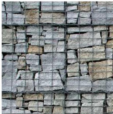
GABIONY JSOU POUŽITY JAKO ZÍDKY, PODEZDÍVKY, AMFITEÁTR (VIZ DÁLE) A JSOU Z NICH VYTVOŘENY TAKÉ LAVIČKY JAKO SOUČÁST "DĚLÍČKŮ" ZÍDEK TAK, ŽE PŘÍSLUŠNÁ KORUNA SPRÁVNĚ VYSOKÉHO GABIONU JE ZAKONČENA PLOCHOU Z MODŘÍNOVÝCH PRKEN.
