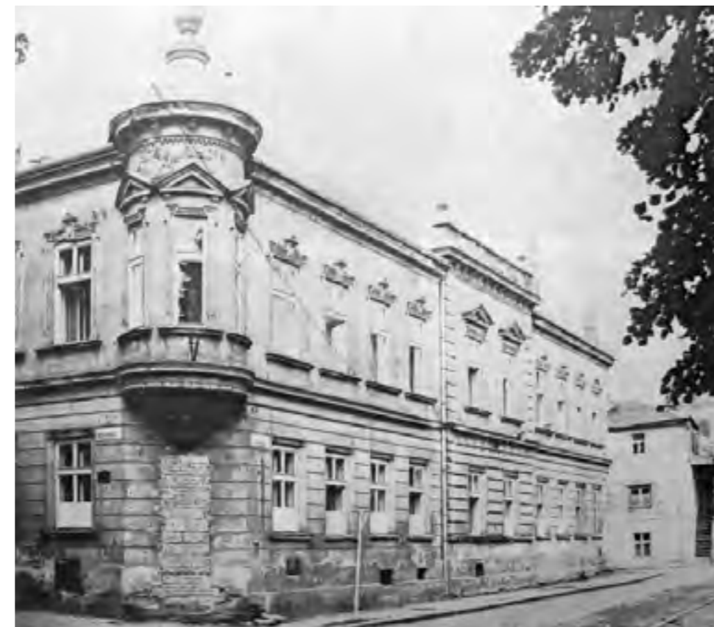
Roh Komenského a Lutínovovy ulice, r. 1973. Původní vstup do židovských uliček.
