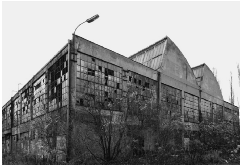
E. HALA Č.19 BÝVALÁ NÁSTROJÁRNA
