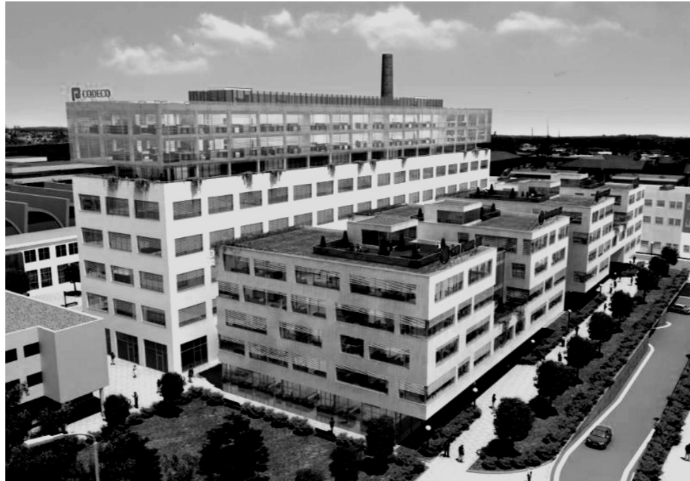
B. ADMINISTRATIVNÍ BUDOVA COLBEN CUBE - VE VÝSTAVBĚ
