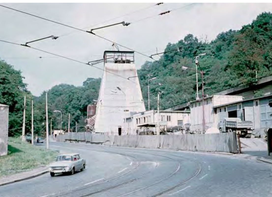
Těžební věž při stavbě metra, 1973;
