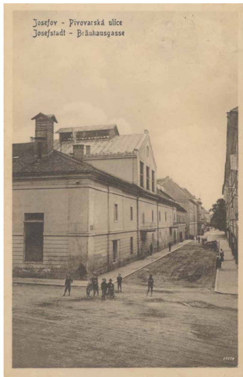
Pivovarská ulice 1924 - balkon, proražení vysokých oken
