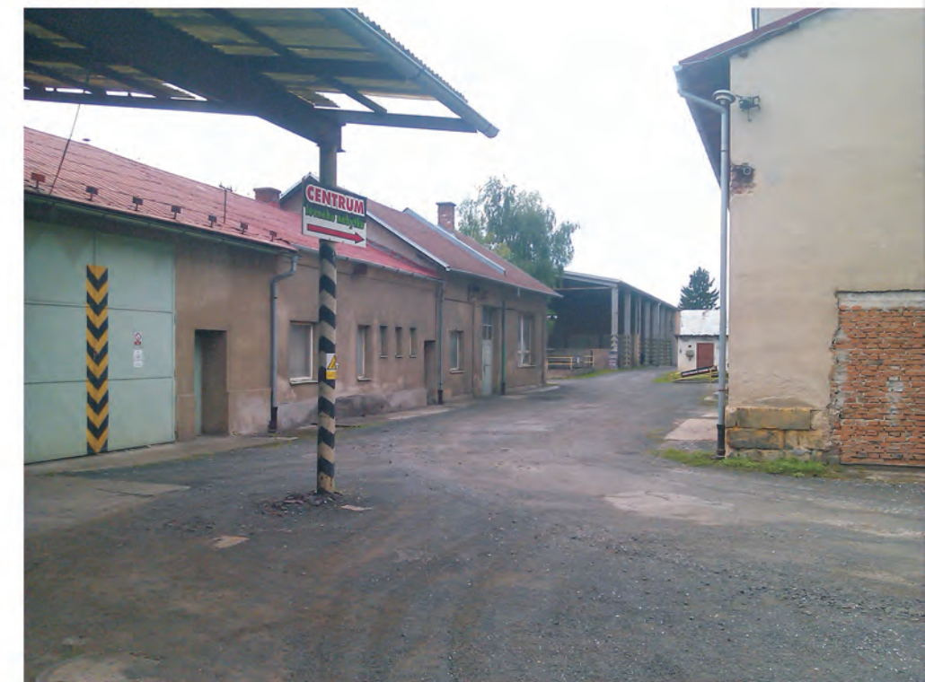
OBJEKT C - DEMOLICE
