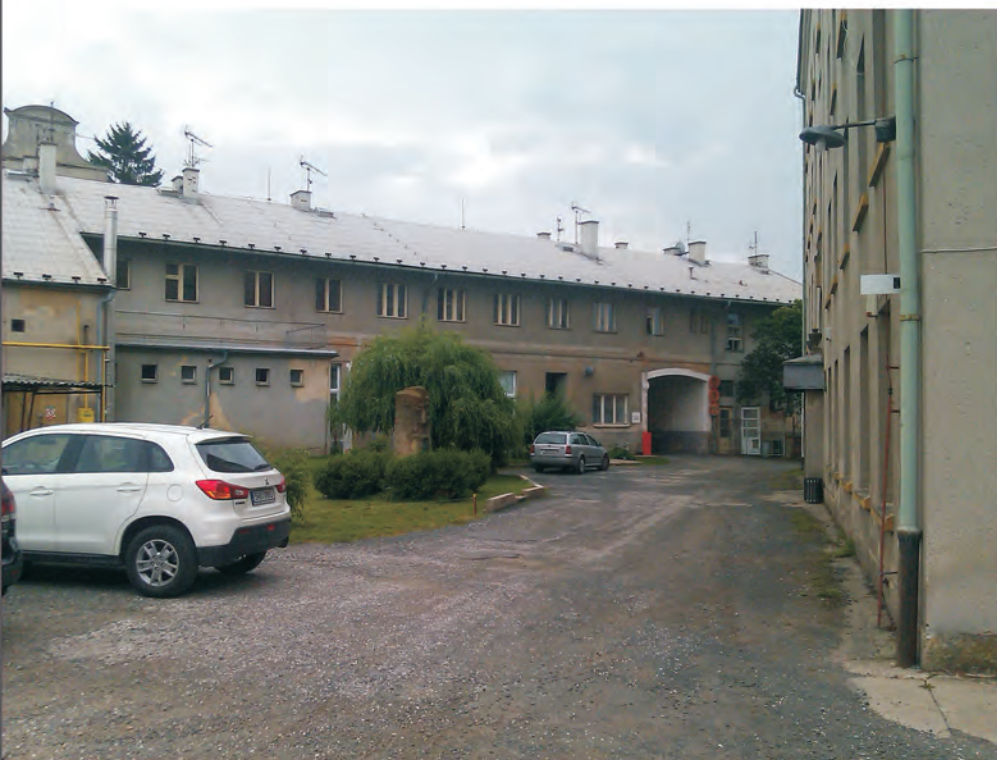
OBJEKT A - DEMOLICE
