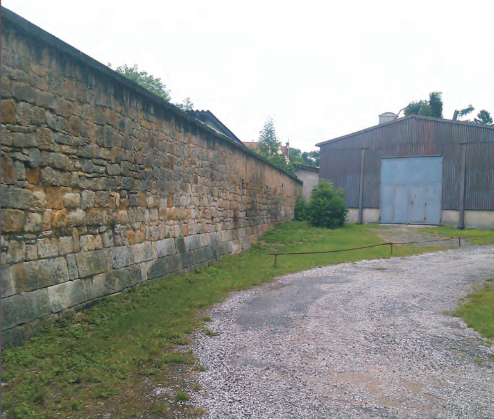
OBJEKT D - DEMOLICE KAMENNÁ STĚNA UZAVÍRAJÍCÍ AREÁL
