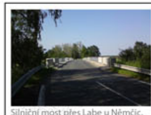
Silniční most přes Labě u Němčic.
