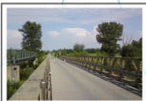
Most mezi opatovickou elektrárnou a Bukovinou slouží především k vyvážení odpadu.
