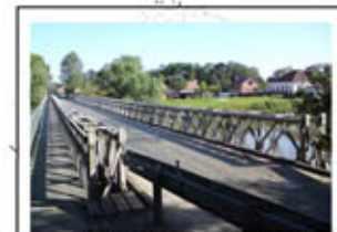
Mnohokrát opravovaný železný silniční most u Sezemic.
