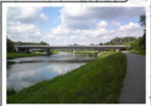
Dálniční a železniční most nad regulovaným tokem Labe v Pardubicích.
