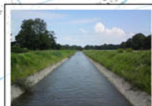
Umělé koryto přivaděče z opatovické elektrárny.
