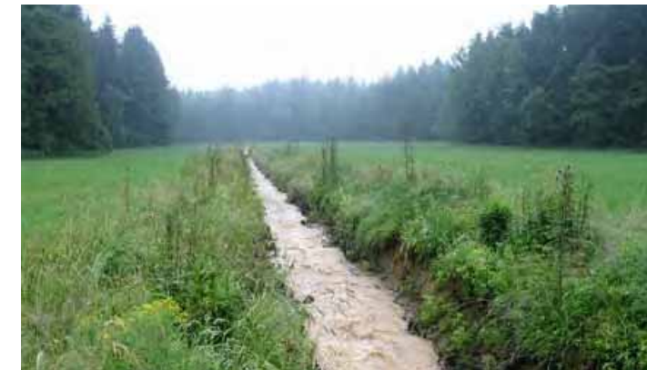
TECHNOLOGICKY UPRAVENÉ v zájmu získávání zemědělských ploch v nivách, jejich odvodnění a ochrany před častějším zaplavením.
