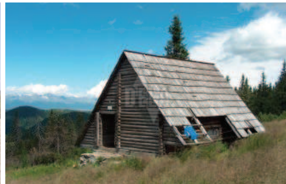
útulňa pred rekonštrukciou
