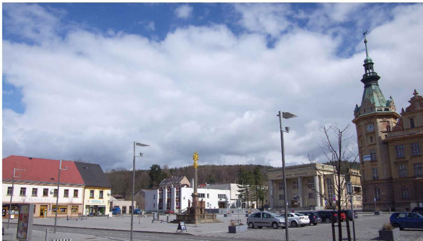
Pohled na řešenou parcelu
