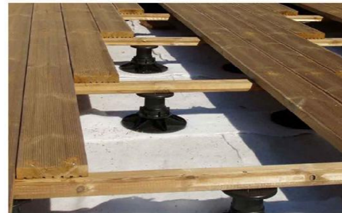
Rošt dřevěné terasy na rektifikačních terčích
