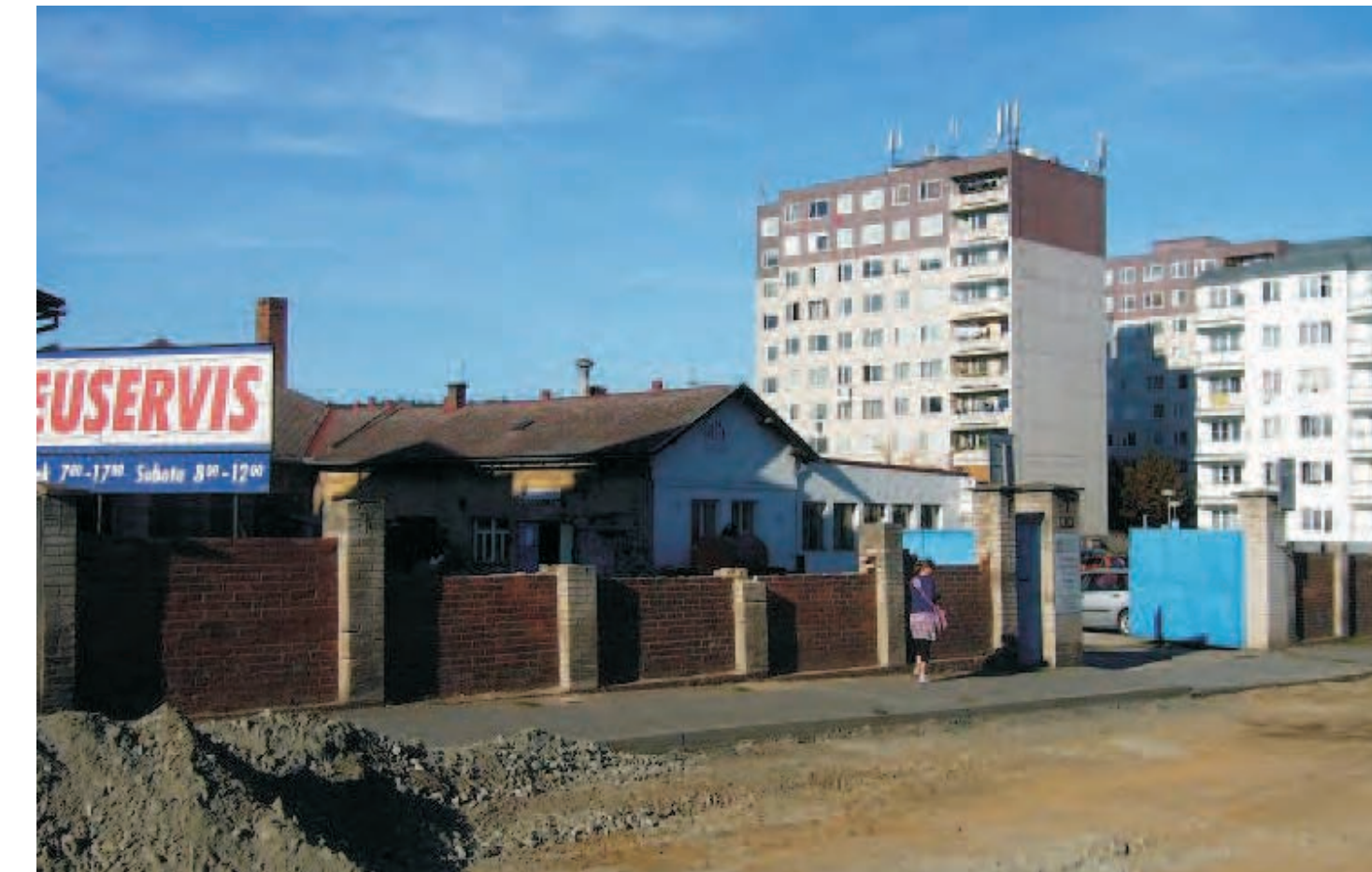
POHLED NA PNEUSERVIS A SÍDLIŠTĚ
