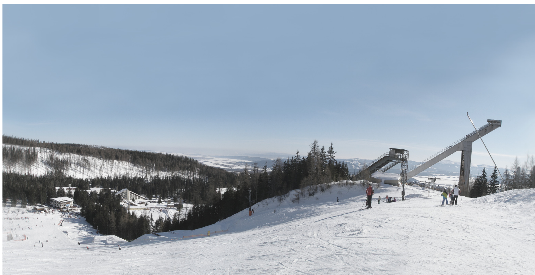
Pohľad na skokanské mostíky z lyžiarskeho svahu Interski
