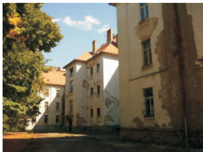
Objekt v areálu bývalých kasáren - jeden ze dvou, které budou zachovány.
