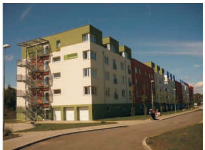
Nová zástavba v blízkosti řešeného území
