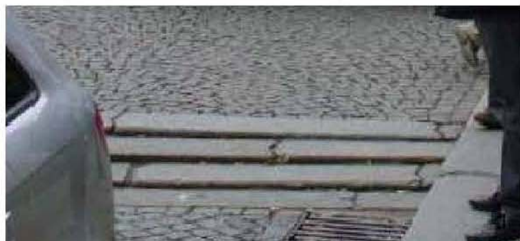
schody vedoucí na parter v úrovni stávajícího chodníku
