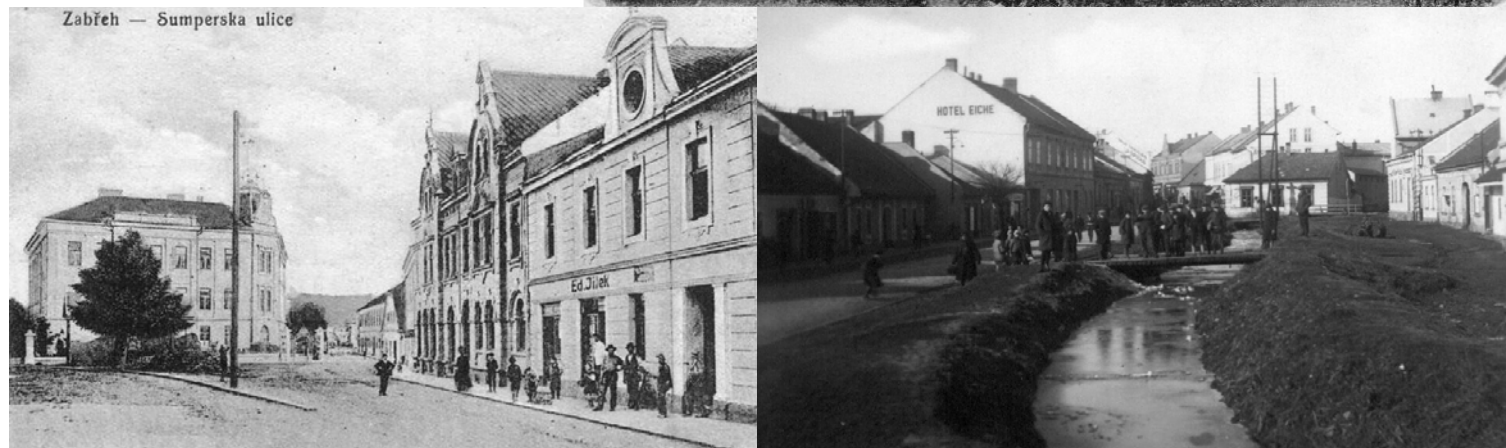
30. léta 20. století – zatrubnění potoka, vydláždění
