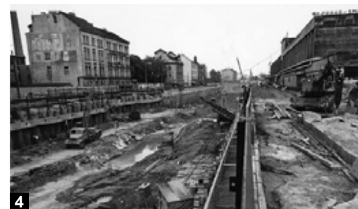
4 Výstavba metra trasy B - Smíchovské nádraží, r. 1979
