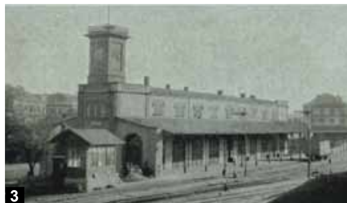
3 Příjezdová budova smíchovského nádraží, před r. 1905
