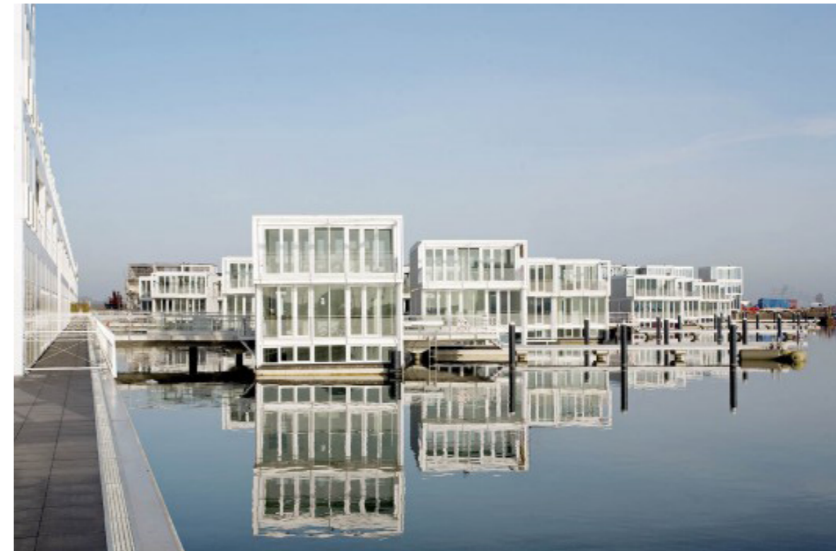
plovoucí domy, Architectenbureau Marlies Rohmer
