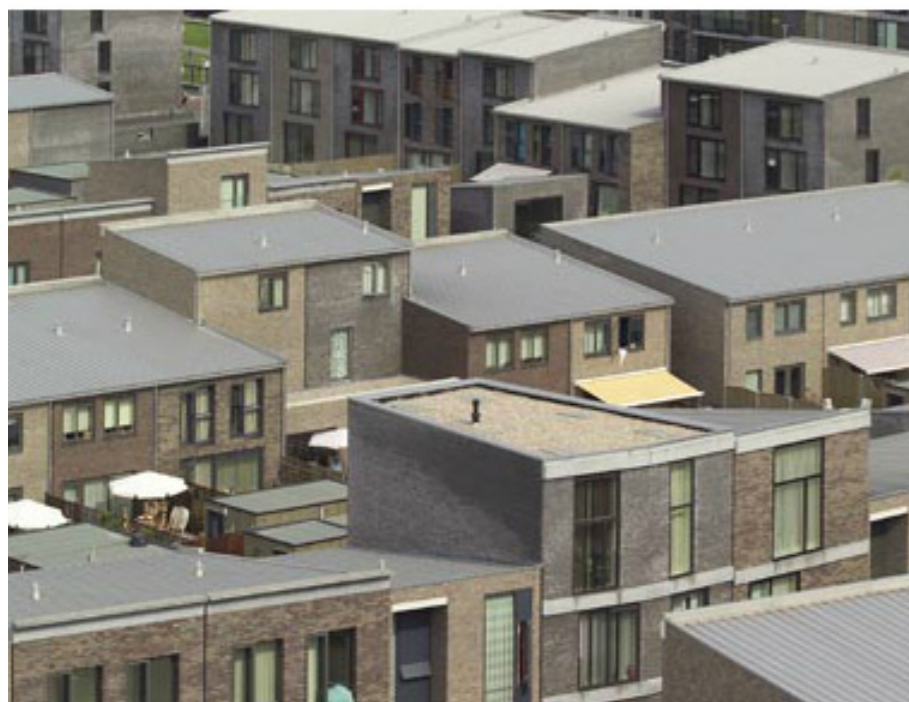
různorodost sklonů střech
