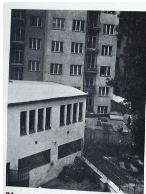
61 Neupravené dvory nových bloků.
