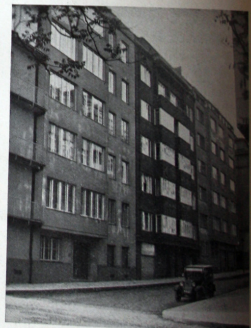
62 Nejednotnost průčelí domů v nové ulici.
