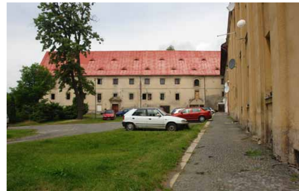
5 Dvůr, pohled na bývalou sýpku
