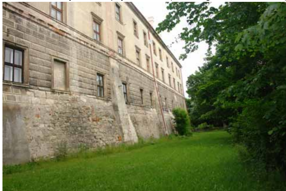
3 Zahrada před jižním průčelím zámku
