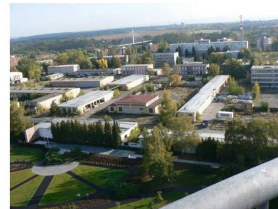
2 - kasárna Jana Žižky před demolicí objektů
