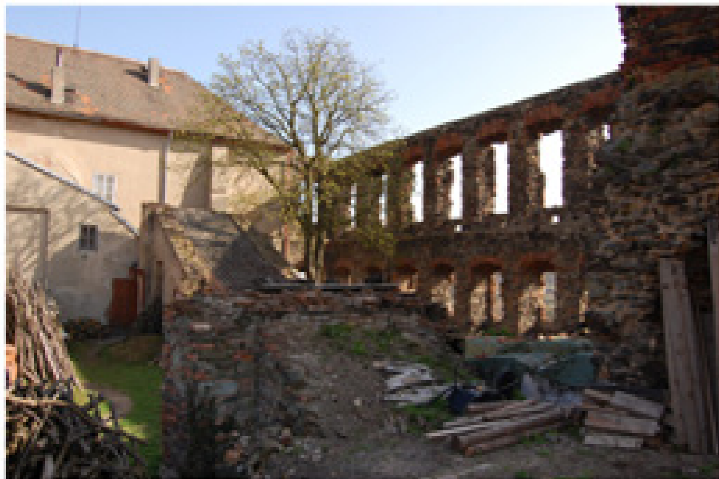
Jihovýchodní křídlo s nedokončeným chodbovým traktem Vstup do gotického sklepa upravený na konci barokní přestavby
