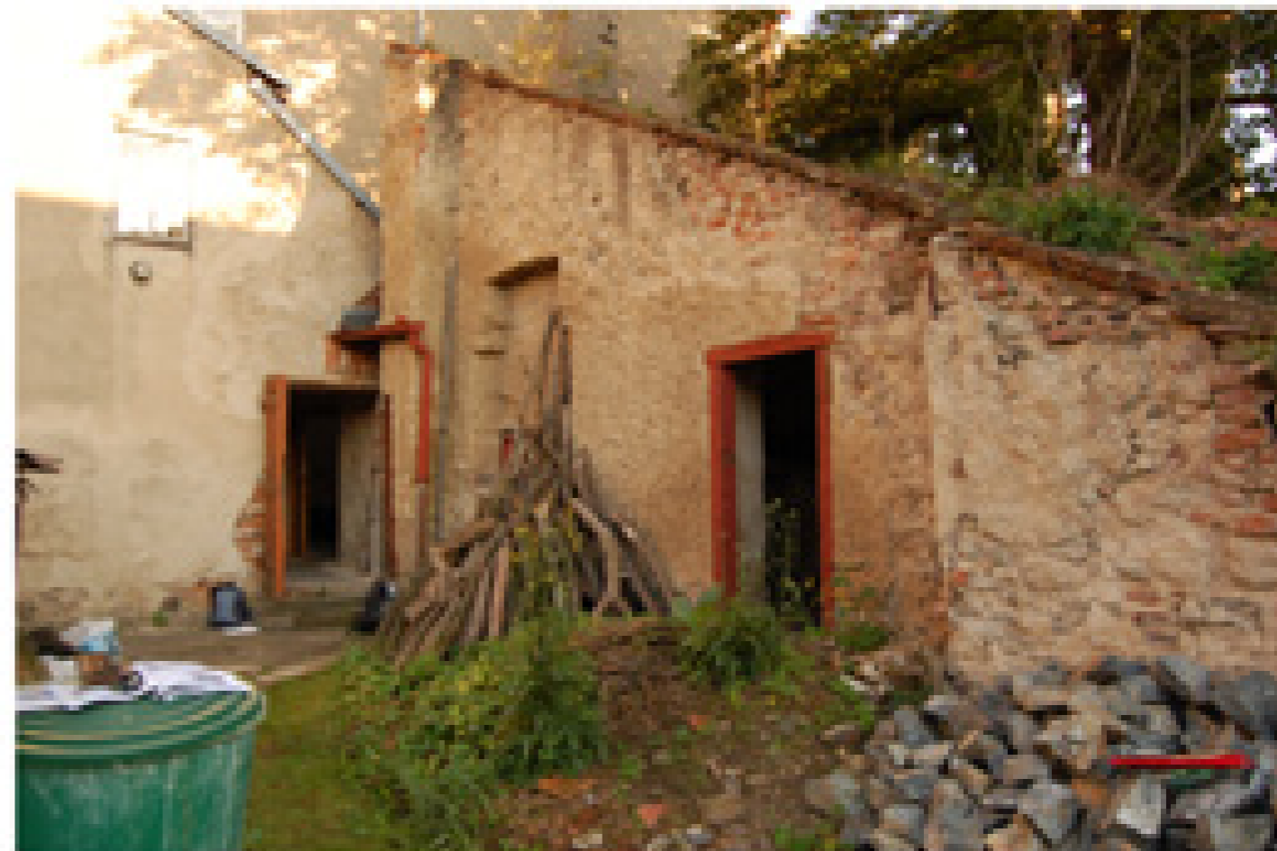
Pozůstatky nedokončeného chodbového traktu SZ křídla
