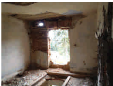
pohled na JZ stěnu
