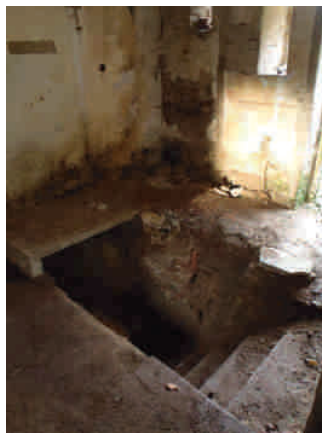
schodiště do sklepa
