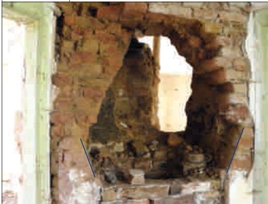
2 - detail uložení segmentového nadpraží otvoru
