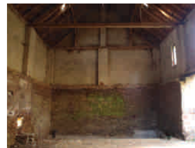
pohled na SZ stěnu
