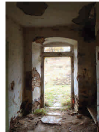
pohled SV stěnu se vstupními dveřmi
