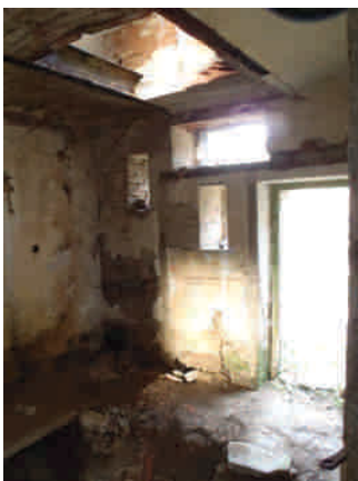
pohled na SV stěnu
