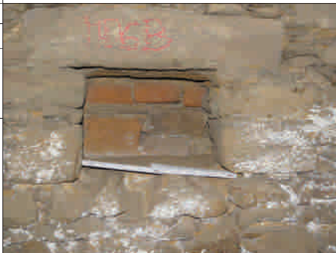
3 - pohled na otvor M06B
