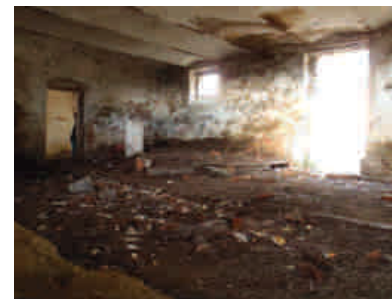
pohled na SV stěnu
