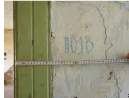
1 - celkový pohled na dveřní otvor ze strany síně 2 - detail profilování zárubně
