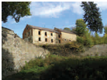
celkový pohled jihozápadního průčelí
