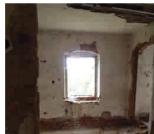
pohled na JZ stěnu
