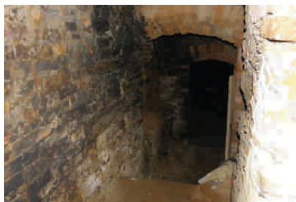
pohled na SZ stěnu chodby rovnoběžné s obvodovou stěnou
