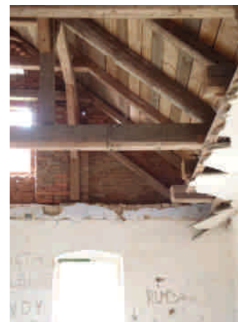
pohled do krovu od JV
