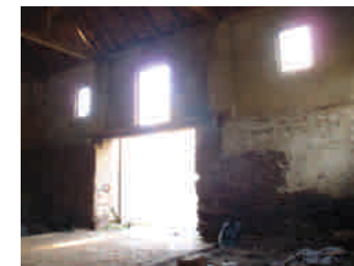
pohled na SV stěnu
