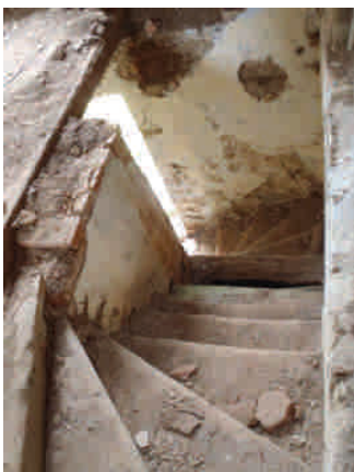
pohled do prostoru schodiště
