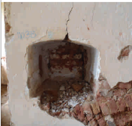
1 - pohled do podávacího okénka z místnosti M03
