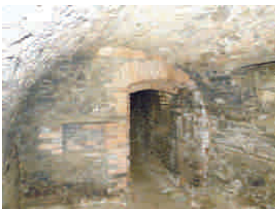
sklep pod M102 pohled na SV stěnu
