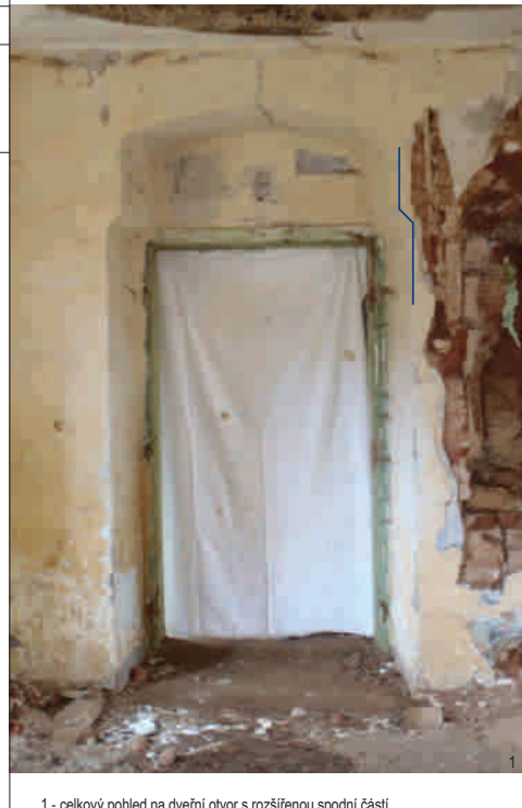
1 - celkový pohled na dveřní otvor s rozšířenou spodní částí
