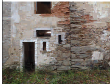
Severovýchodní průčelí - spára ve zdivu určující hranici obytného traktu do roku 1930.
