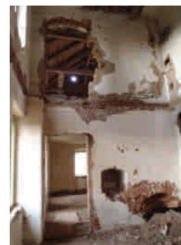
pohled na SZ stěnu
