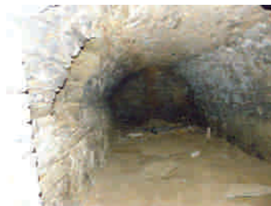
sklep pod M102 pohled na SZ stěnu
