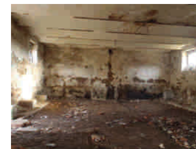
pohled na JV stěnu
