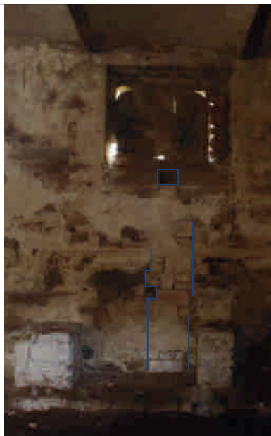
2 - pohled na vysekáný a přizdžený otvor na odvod kondenzátu
