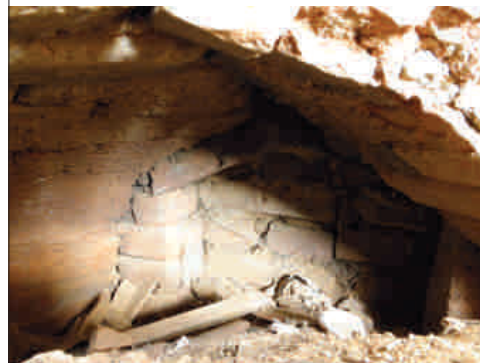
6 - pohled do pece z místnosti M03 směrem do M01
