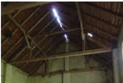
pohled do krovu od JV
