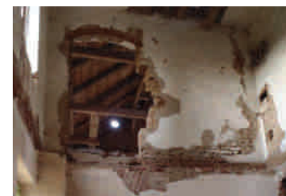
pohled na SZ stěnu
