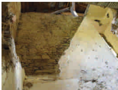
pohled na JV stěnu
