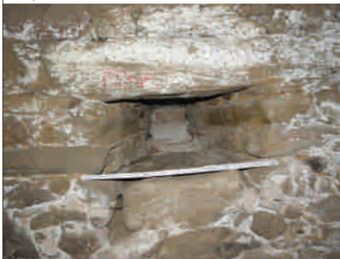
4 - pohled na otvor M06A
