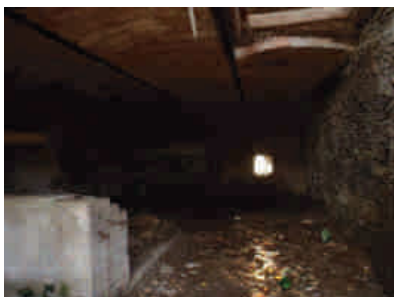
pohled na JZ stěnu
