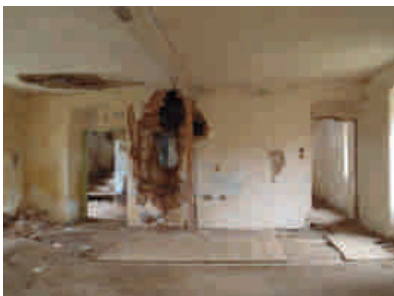
pohled na JV stěnu
