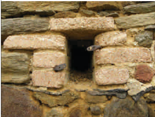
1 - pohled z exteriéru na ústí kanálku pro odvod kondenzátu
