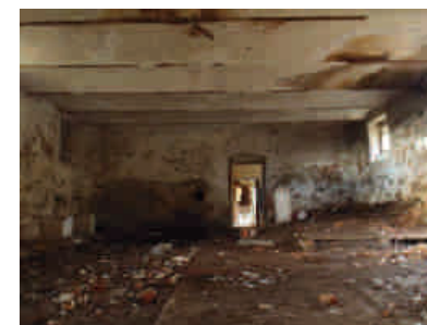
pohled na SZ stěnu
