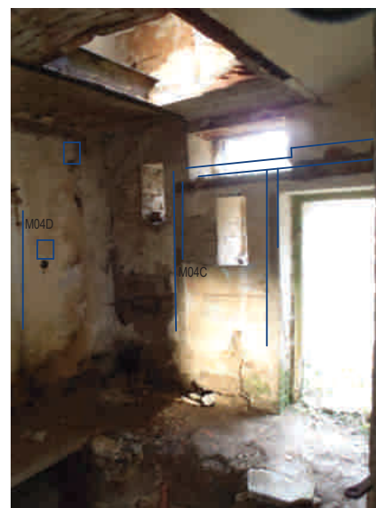
1 - pohled do dřívějšího prostoru zádveří a WC
