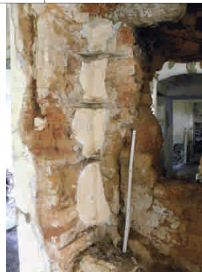
1 - pohled do policové niky, dříve segmentově zaklenuté 2 - pohled na klenebný pas, jež roznášel zdivo nad chlebovou pecí
