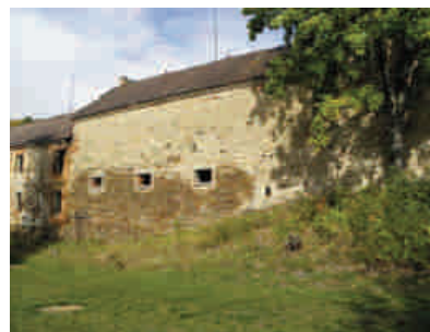
díličí pohled na střední, hospodářský trakt jihozápadního průčelí
