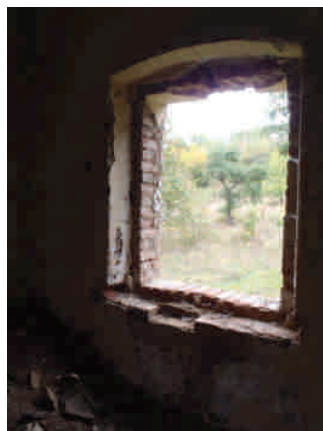
pohled na SV stěnu
