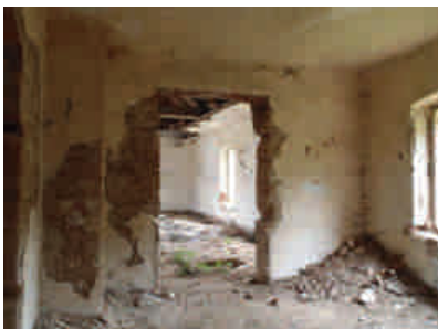
pohled na SZ stěnu
