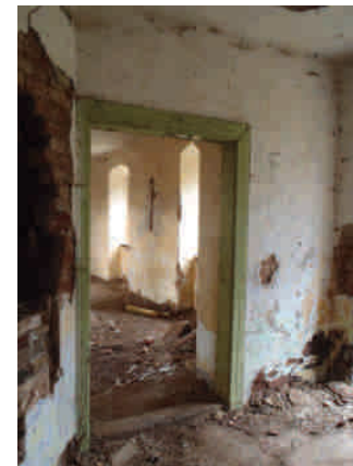
pohled na vstup do M102, SZ stěna
