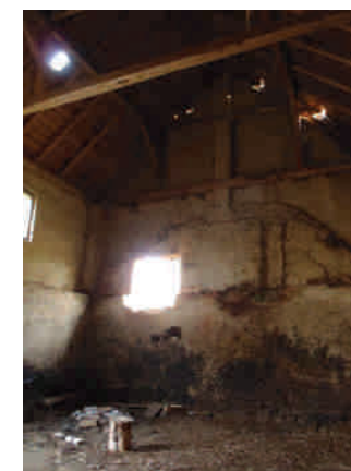
pohled na JV stěnu
