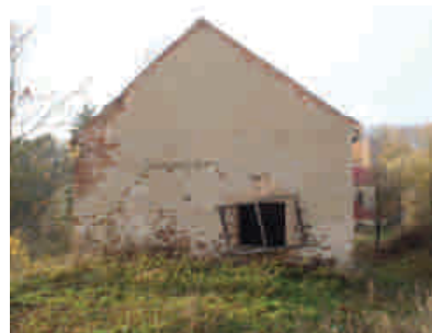
jihovýchodní průčelí, štít stodoly
