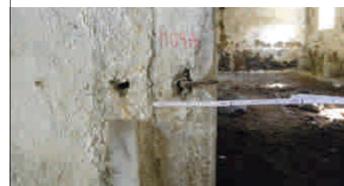
3 - v kamenném ostění vstupu do chléva vsazeno kovové oko na zavírání
