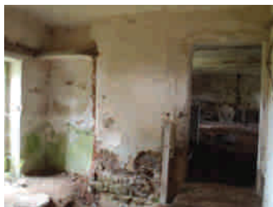
pohled na JV stěnu
