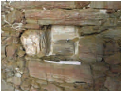
2 - pohled na otvor M07A
