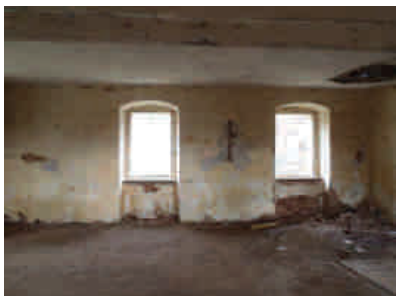
pohled na SV stěnu
