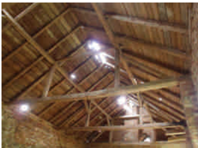
pohled do krovu od JV
