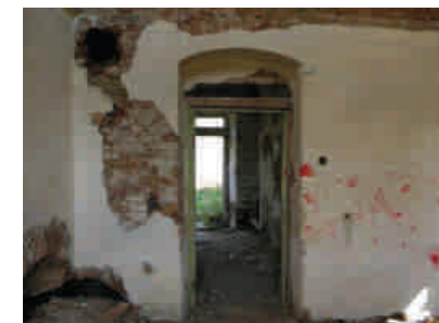
pohled na dveře v SV stěně
