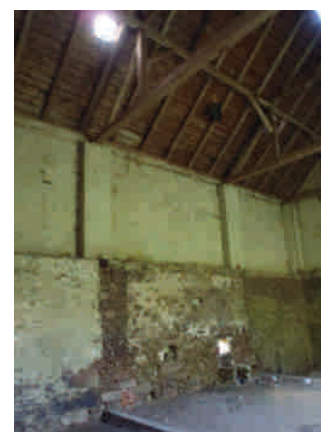
pohled na JZ stěnu
