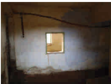
pohled na JZ stěnu
