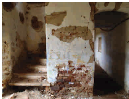
pohled na schodiště do patra v JV stěně
