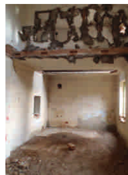
pohled na JV stěnu
