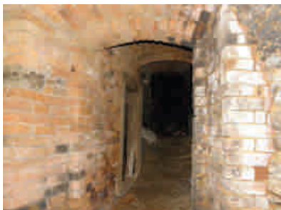
pohled na SV stěnu chodby rovnoběžné s obvodovou stěnou
