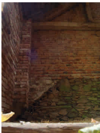
pohled na JV stěnu
