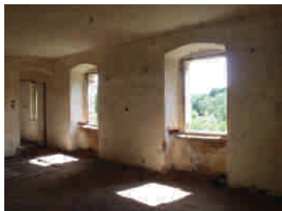
pohled na JZ stěnu
