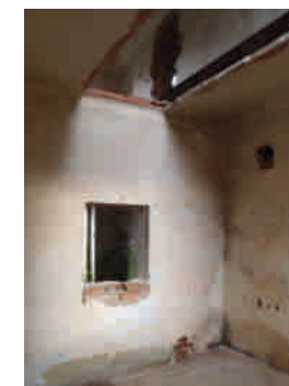
pohled na SV stěnu
