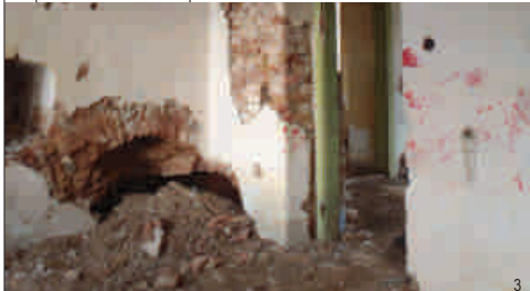
3 - pohled do torza chlebové pece, která byla situována pod křížením zdí
