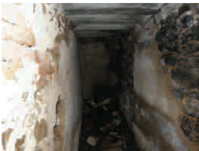
pohled na SV stěnu v chodbě
