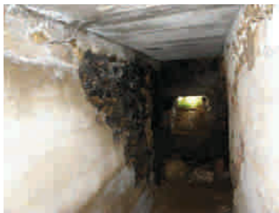
pohled na JZ stěnu chodby
