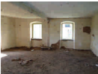
pohled na SZ stěnu
