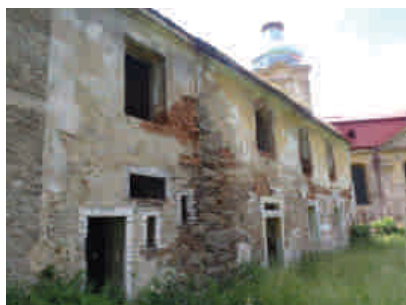
obytná část severovýchodního průčelí
