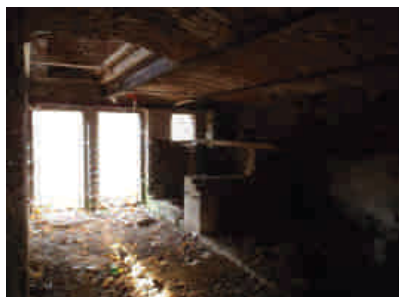
pohled na SV stěnu
