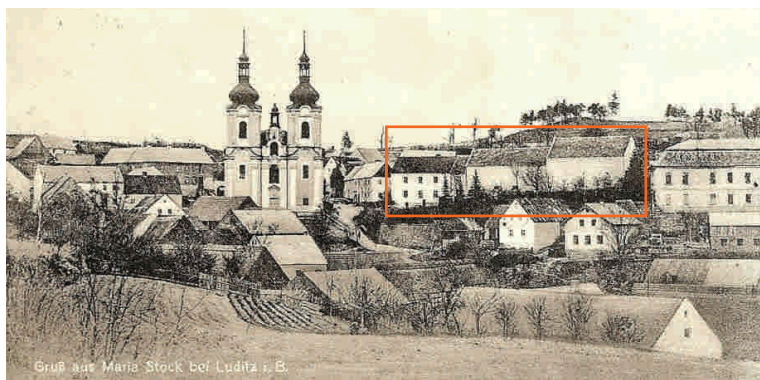
fotografie po roce 1930 zachycuje objekt po další přestavbě, při níž byl rozšířen obytný trakt a vzesstupně směrem na východ zvýšeny hospodářské stavby
