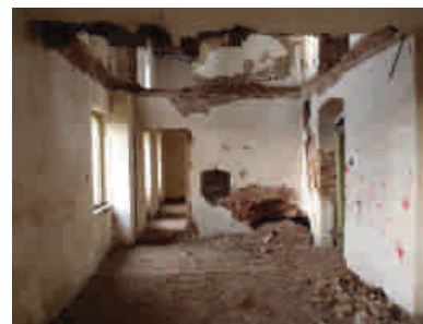
pohled na SZ stěnu
