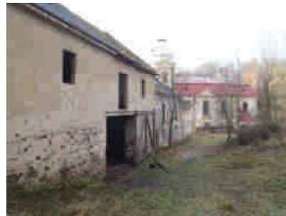
pohled od jihovýchodu
