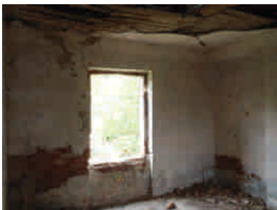
pohled na SV stěnu
