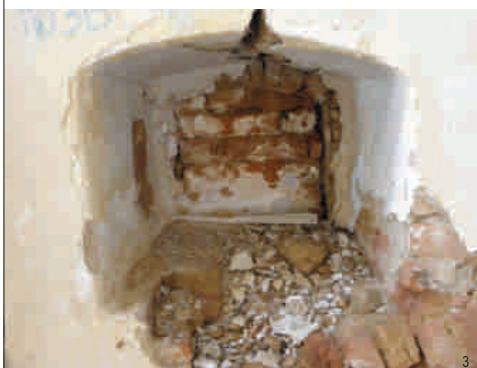
3 - detail podávacího okénka s dodatečnou zazdívkou
