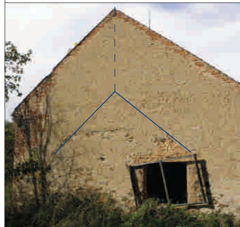
V jihovýchodním štítu stodoly se v cihelném zdivu z přestavby kolem roku 1930 propisuje starší kamenný štít, snížený stodoly, která nahradila spalnou stodolu v poslední čtvrtině 19.stol.
