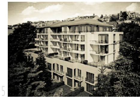
Bytová výstavba Kajetánka
