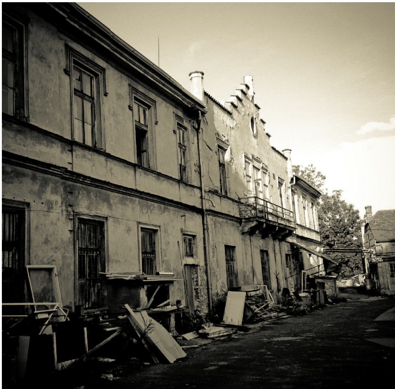
FOTOGRAFIE SOUČASNÉHO STAVU USEDLosti PETYNKA - BUDOVA BÝVALÉHO VINCENTINA
