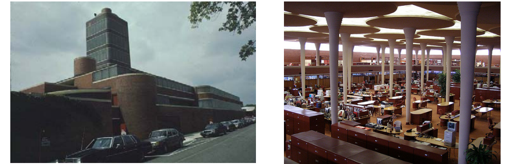
Johnson Wax building, exteriér a interiér velké pracovny s pohledem na hřibové hlavice sloupů.
