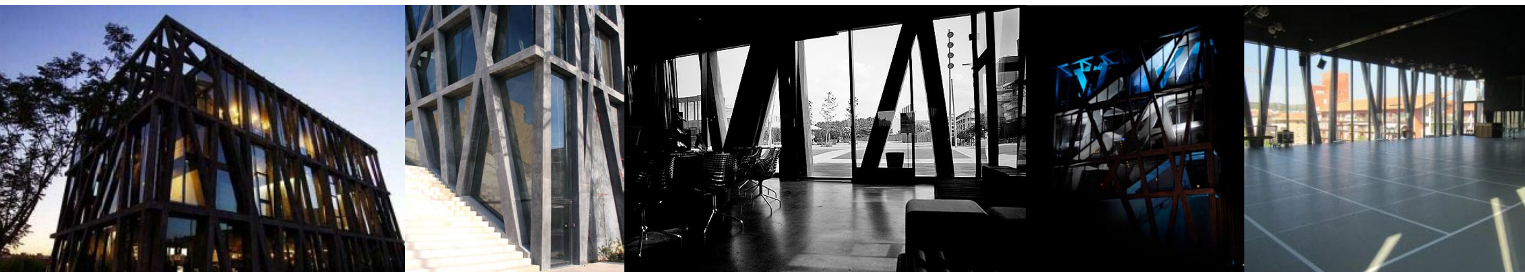
Pavillon Noir | Rudy Ricciotti | Aix en Provence, Francie | novostavba národního choreografického centra | + fasáda= železobetonová nosná konstrukce
